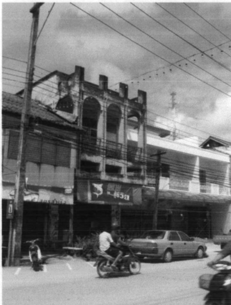
A46 อาคารพาณิชย์ริมถนนเพชรเกษม
