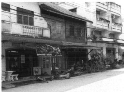
E09 บ้านพักอาศัยริมถนนเทศบาล 6
