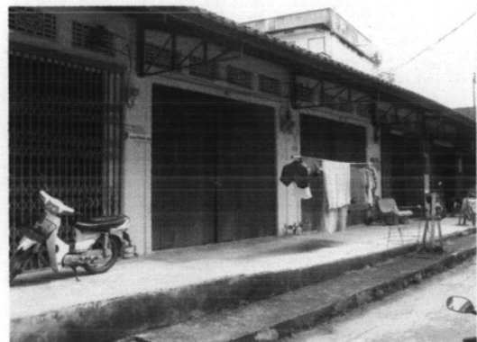
E10 บ้านพักอาศัยริมถนนเทศบาล 10
