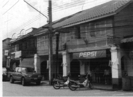
A45 อาคารพาณิชย์ริมถนนเพชรเกษม
