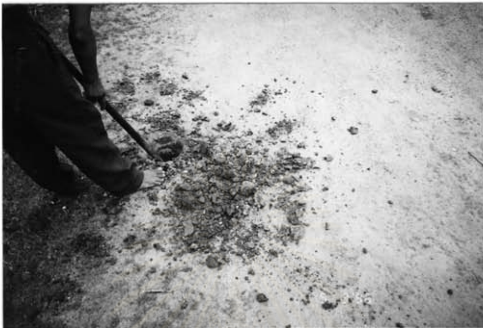
รูปที่ 3-27 แสดงการเตรียมติดตั้งสายสัญญาณโดยขุดดินลึก 15 ซม. เพื่อติดตั้งสายสัญญาณ
