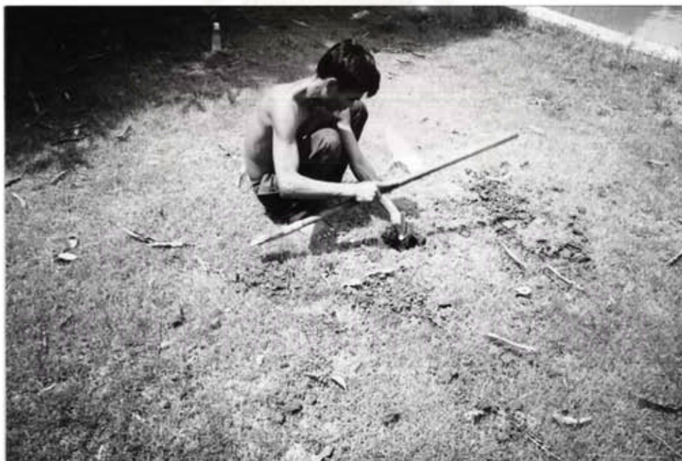
รูปที่ 3-28 แสดงการติดตั้งแทนขั้วสายสัญญาณโดยคอกแทนลงไปดินเพื่อไม่ให้ดินที่ตกลงไปเปลี่ยนแปลงเนื่องจากสัมผัสอากาศ
