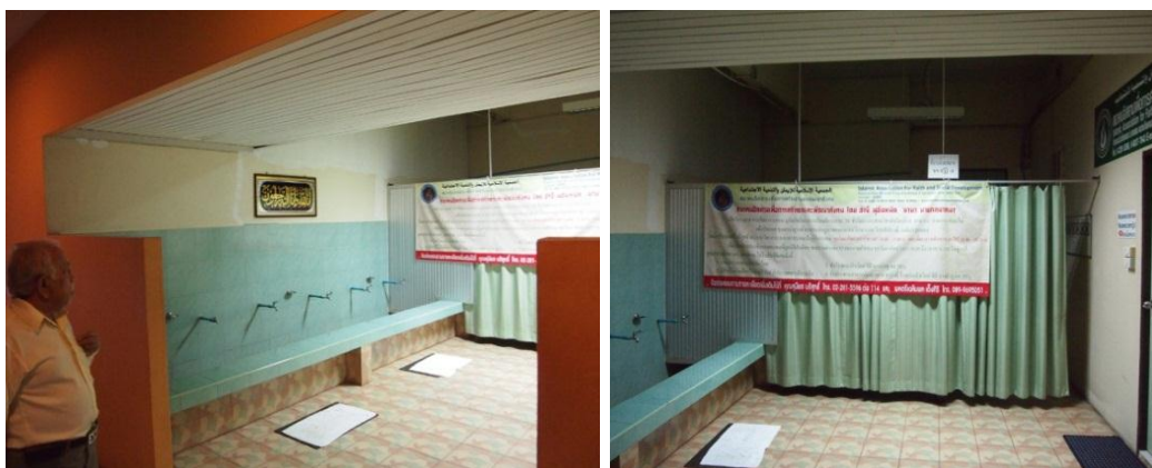
ภาพที่ 4.7 แสดงบริเวณห้องอาบน้ำละหมาดโรงแรมนูโวซิตี
