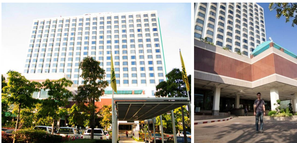
ภาพที่ 4.67 แสดงลักษณะภายนอกอาคารลิโอบบี้
