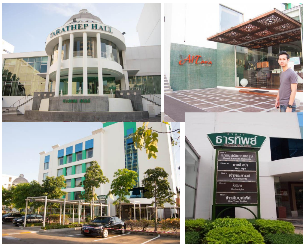
ภาพที่ 4.68 แสดงอาคารธาราทิพย์และอาคารธารทิพย์
