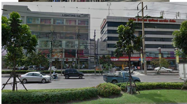
ภาพที่ 4.65 แสดงอาคารสำนักงานและสถานีรถไฟฟ้าใต้ดินรัชดาบริเวณใกล้เคียงโรงแรมเจ้าพระยาปาร์ค
