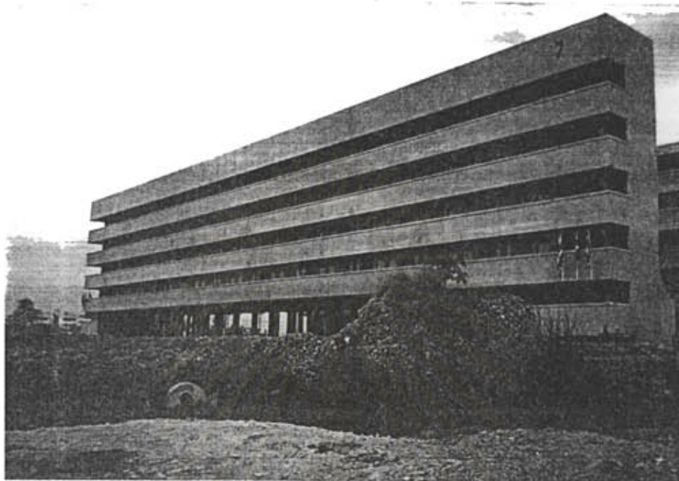
ภาพที่ 1 ตัวอาคารและห้องพักภายในอาคารสงเคราะห์ประเวศ ที่เพิ่งสร้างเสร็จและอยู่ในระหว่างปรับปรุงเพื่อเข้าอยู่อาศัย
