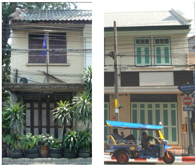
ภาพที่ 4.5 แสดงลักษณะทางสถาปัตยกรรมอาคาร 9 ห้อง ถนนพระอาทิตย์
