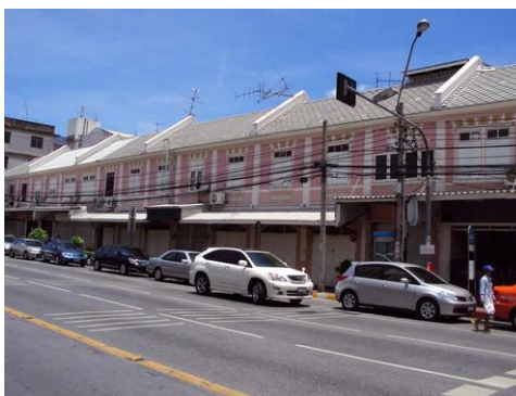
ภาพที่ 4.3 แสดงลักษณะทางสถาปัตยกรรมอาคารตลาดนางเลิ้ง
