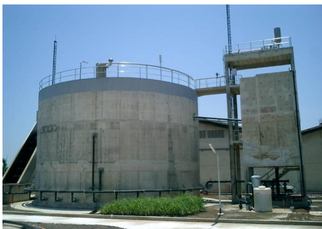
ภาพที่ 2.14 ระบบยูเอเอสบี (ศูนย์วิศวกรรมพลังงาน.
