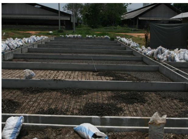
ภาพที่ ก-1.2 ลานตากตะกอนและระบบทำความสะอาดก๊าซ
