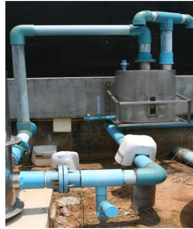
ภาพที่ 3.7 ตำแหน่งวัดอัตราการไหลของก๊าซชีวภาพ
