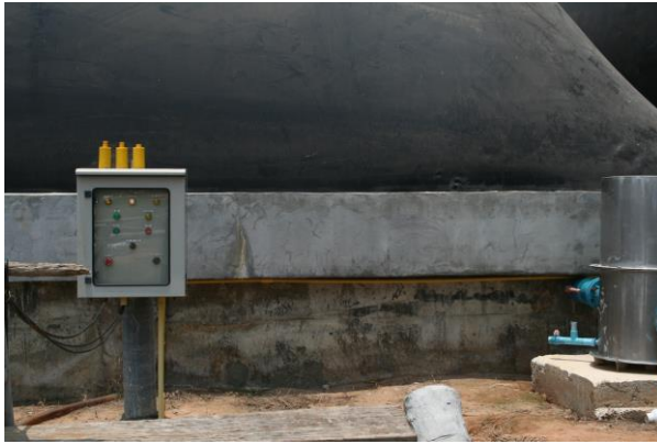
ภาพที่ 3.7 ตำแหน่งวัดอัตราการไหลของก๊าซชีวภาพ
