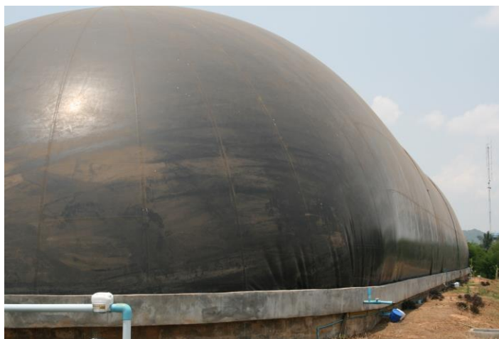
ภาพที่ 3.11 ระบบผลิตก๊าซชีวภาพของฟาร์มตัวอย่าง
