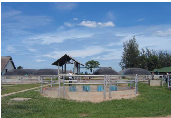
ภาพที่ 2.11 ระบบก๊าซชีวภาพฟาร์มสุกร (กรมควบคุมมลพิษ, 2552)
