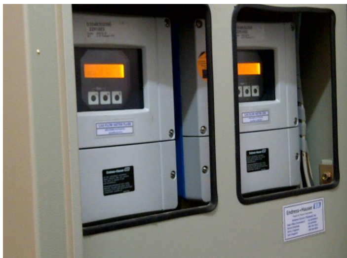
ภาพที่ ก-1.3 เครื่องประมวลผลอัตราการไหลของน้ำและก๊าซ
