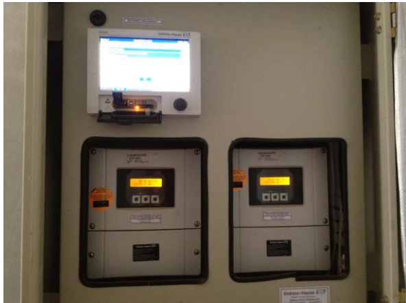
ภาพที่ 3.8 เครื่องประมวลผลข้อมูลอัตราการไหลน้ำเสียที่เข้าระบบ และก๊าซชีวภาพที่ผลิตได้
