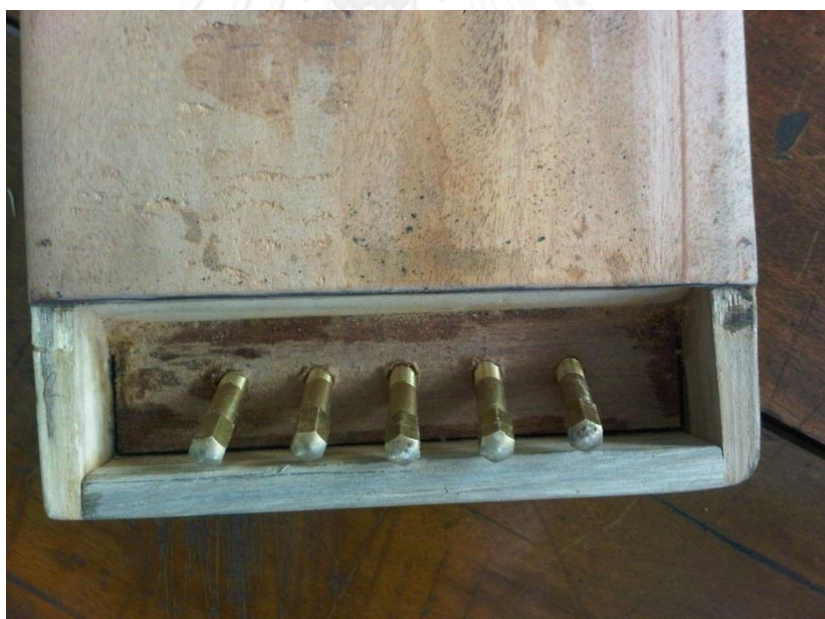
ภาพที่ 35 ตำแหน่งหลักยึดสายสำหรับเครื่องสี่ ในการออกแบบครั้งที่ 6
