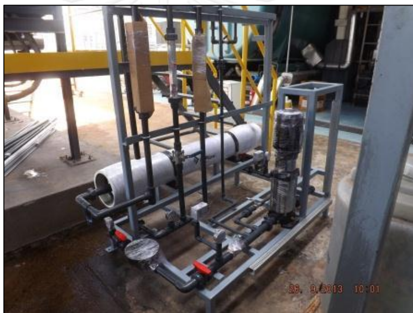
รูปที่ 4. 6 อุปกรณ์ Reverse osmosis สำหรับผลิตน้ำ R.O. ใช้ในระบบเคมี Coating
