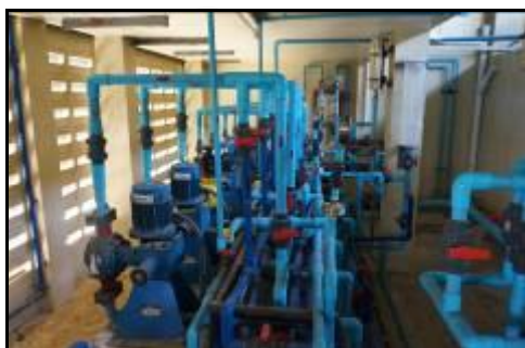
รูปที่ 4.8 ปัมป์จ่ายสารส้มและท่อแบบกวนผสมในเส้นท่อของการประปาส่วนภูมิภาคสาขาเชียงราย
