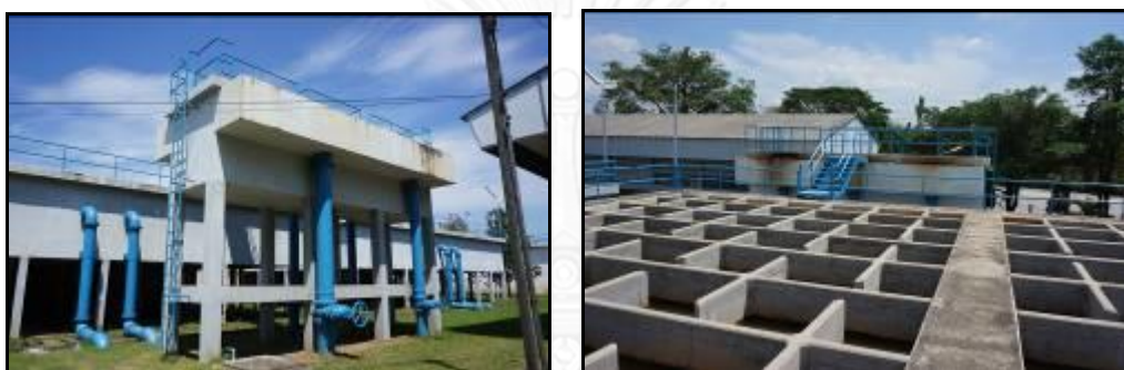
รูปที่ 4.9 หอแบ่งน้ำและถังกวนช้าแบบแผ่นกั้นของการประปาส่วนภูมิภาคสาขาเชียงราย
