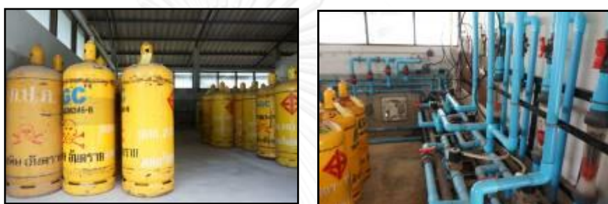
รูปที่ 2.3 ถังแก๊สคลอรีนและระบบการเติมลงในน้ำประปา
