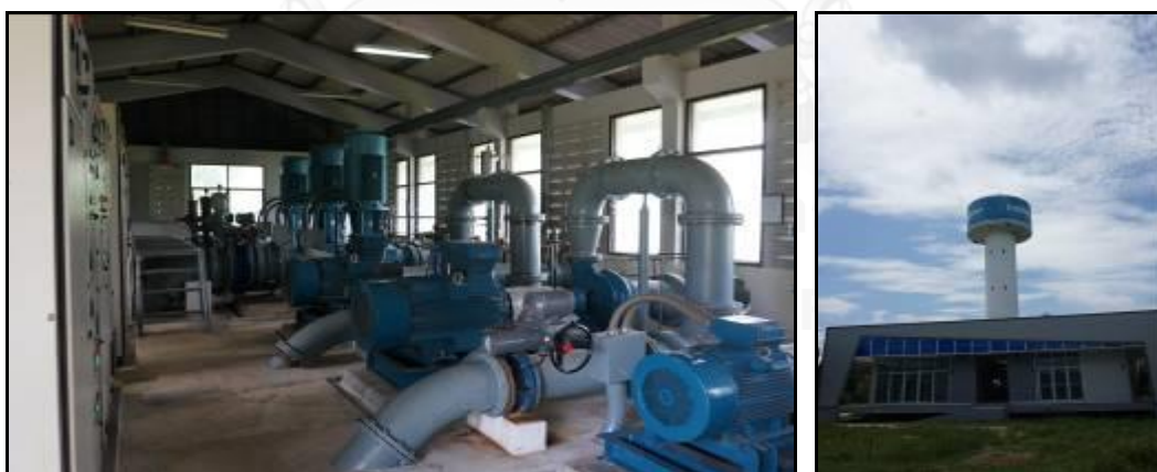
รูปที่ 4.14 เครื่องสูบน้ำและหอดังสูงของการประปาส่วนภูมิภาคสาขาเชียงราย
