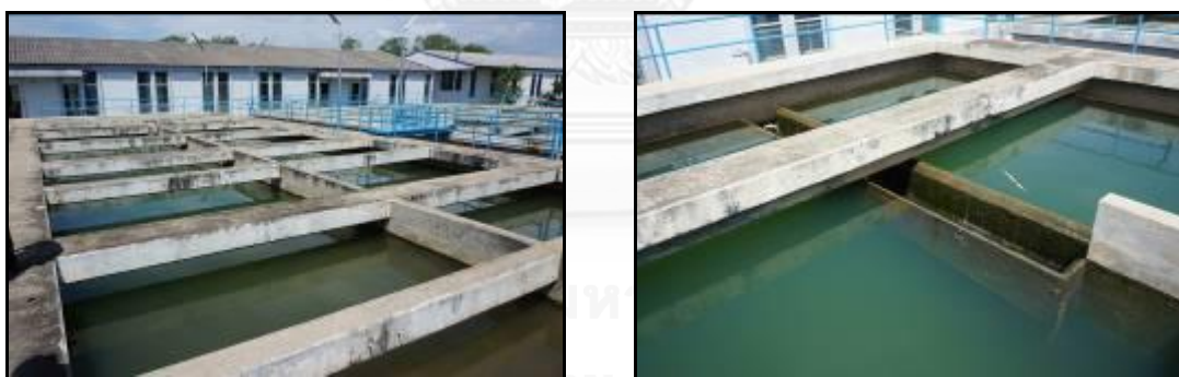
รูปที่ 4.10 ถังตกตะกอนแบบสี่เหลี่ยมของการประปาส่วนภูมิภาคสาขาเชียงราย
