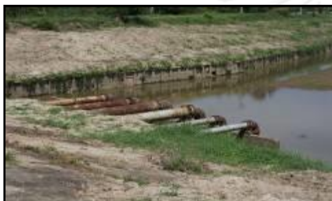
รูปที่ 4.7 จุดสูบน้ำดิบและเครื่องสูบน้ำของโรงผลิตน้ำประปาส่วนภูมิภาคสาขาเชียงราย
