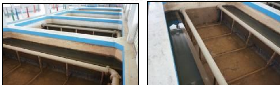
รูปที่ 2.2 ถังกรองที่ใช้ทรายเป็นชั้นกรอง
