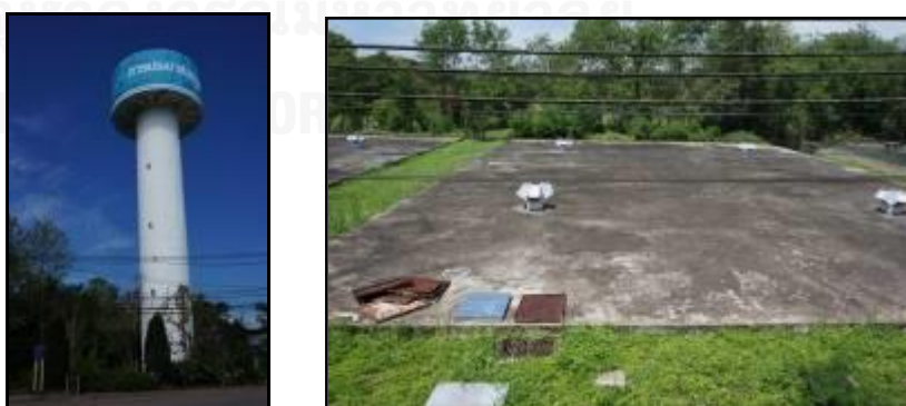
รูปที่ 2.4 รูปแสดงถังเก็บน้ำใสแบบหอสูงและแบบถังเก็บใต้ดิน
