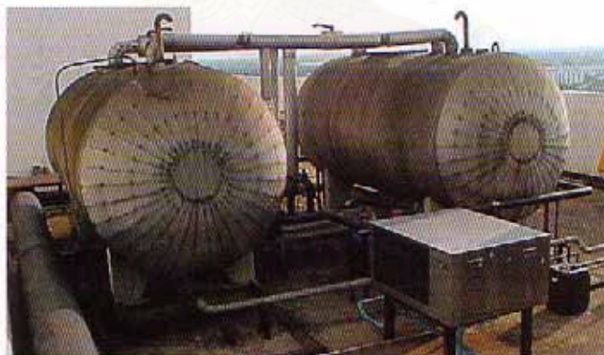
รูปที่ ข.16 แสดงการติดตั้งถังเก็บน้ำร้อน
