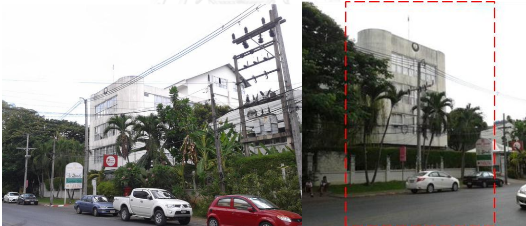
ภาพที่ 10 ภาพถ่ายภายนอกสำนักงาน H
