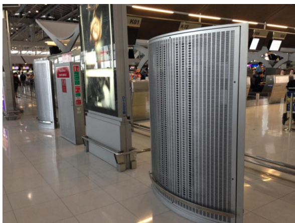
รูปที่ 1. 1 ระบบปรับอากาศแบบแทนที่ซึ่งถูกใช้งานที่สนามบินสุวรรณภูมิ
