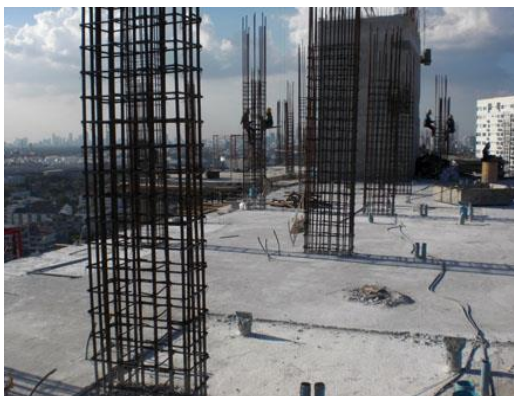
รูปที่ 4.27 เหล็กเสริมหลักในเสา (ภาพจาก http://ideocondo.com )
