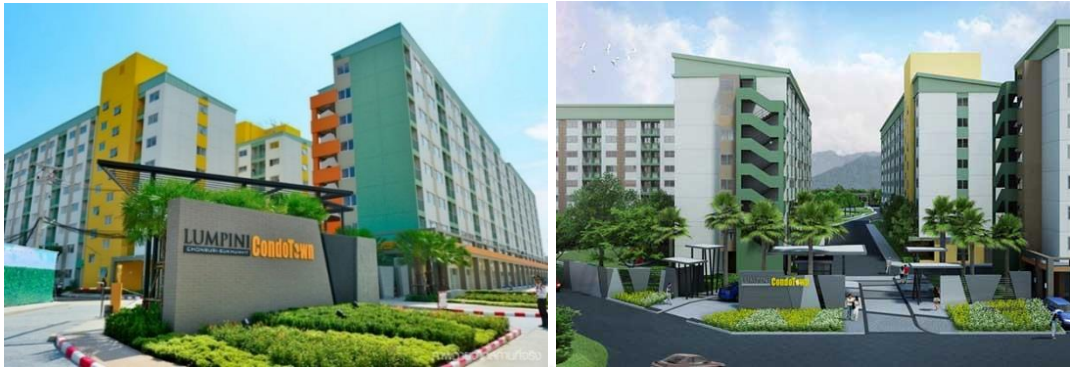
รูปที่ 3.2 ภาพถ่ายโครงการจริงและภาพแบบจำลองจากเว็บไซต์ www.lpn.co.th
