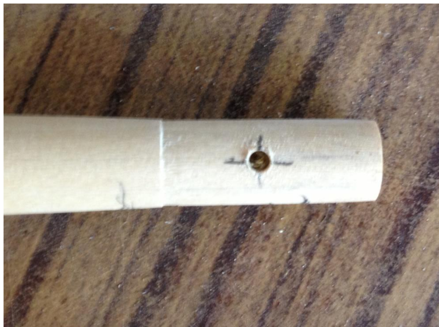
ภาพที่ ๑๘๔ ลักษณะรูร้อยสายที่ถูกเจาะทะลุ
