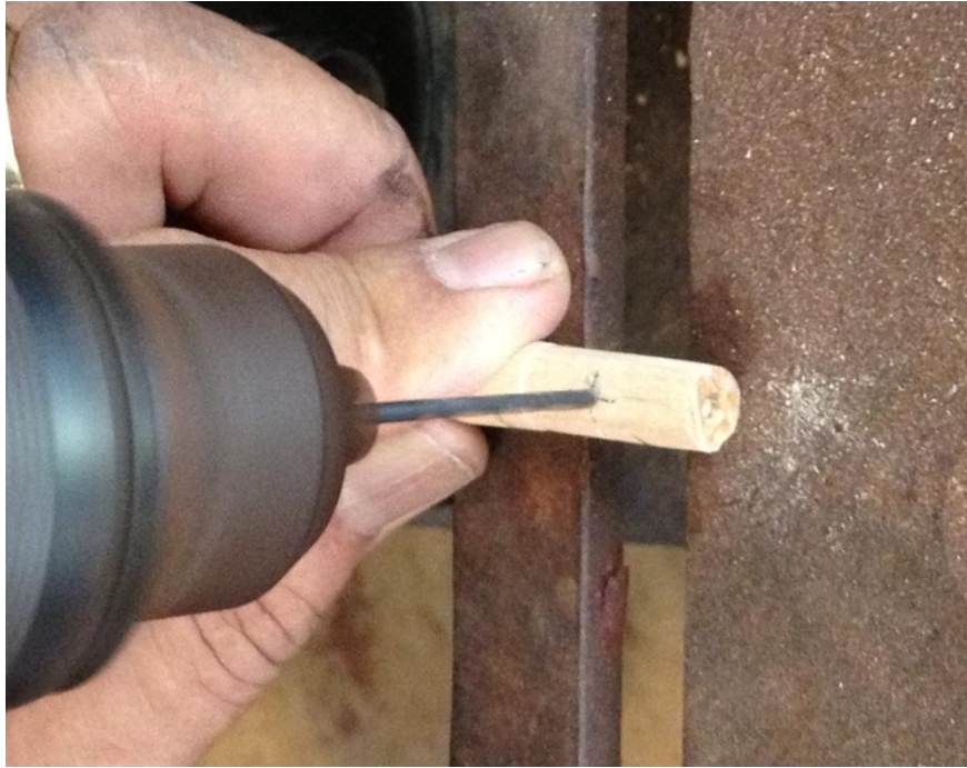
ภาพที่ ๑๘๓ การใช้สว่านเจาะรูร้อยสายลูกบิด
