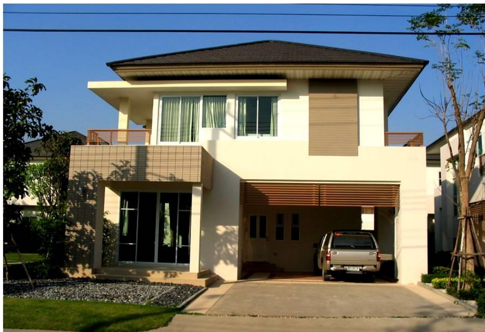
ภาพที่ 1.2 แสดงบ้านเดี่ยวที่ผนังใช้วัสดุที่ก่อด้วยอิฐพร้อมฉาบปูนเรียบ หมู่บ้านชลดา อ.เมือง จ.สระบุรี
