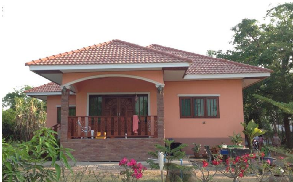
ภาพที่ 3.5 บ้านเดี่ยวติดตั้งด้วยผนังคอนกรีตบล็อก อำเภอเมือง จังหวัดสระบุรี
