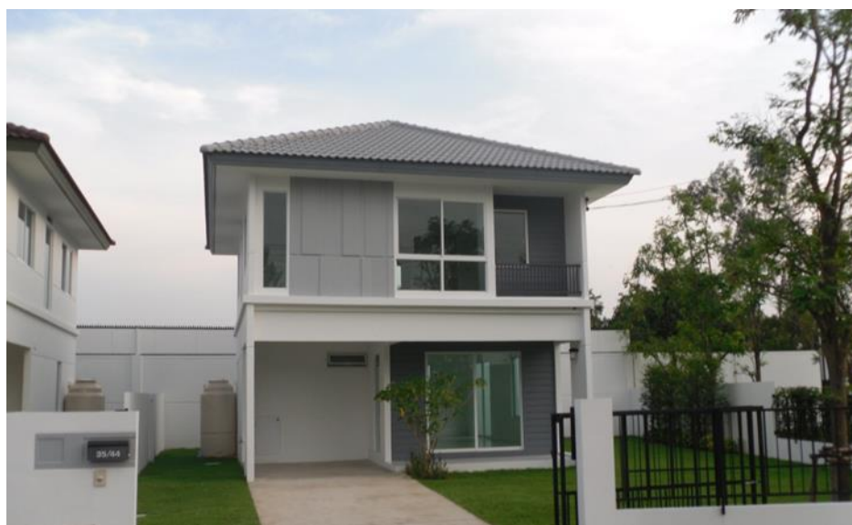
ภาพที่ 3.9 บ้านเดี่ยวติดตั้งผนังคอนกรีตสำเร็จ (Pre cast) อำเภอเมือง จังหวัดสระบุรี
