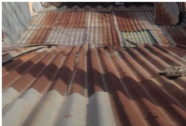
ภาพที่ 4.34: กระเบื้องลอนคู่ที่ใช้มุงหลังคาใหม่ (ด้านบน) และเก่า (ด้านล่าง)
