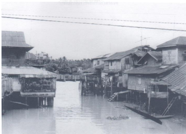
ภาพที่ 4.31: ชุมชนตลาดบ้านใหม่บริเวณสะพานไม้ จุดเชื่อมต่อระหว่าง 2 ชุมชน (ภาพแนวนอน) ที่มา: (แนะนำจังหวัดฉะเชิงเทรา ฉบับอำเภอเมือง, 2547)
