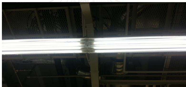
รูปที่ 5.6 หลังการปรับปรุงมาตรการ 5 (เปลี่ยนหลอดไฟฟ้าเป็นหลอด LED)
