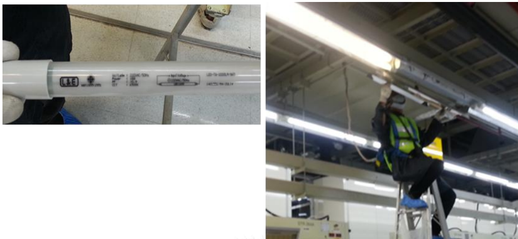
รูปที่ 5.5 ก่อนการปรับปรุงมาตรการ 5 (เปลี่ยนหลอดไฟฟ้าเป็นหลอด LED)
