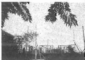
ติดตั้งวงกบหน้าต่าง ก่อนล็อกช่วง ที่ 2 จากท้องวงกบถึงหลังวงกบ วันที่ 29/10/2542 (ทำงานจริงได้ 12 วัน)
