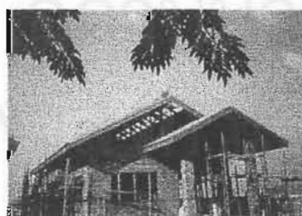
มุงหลังคา วันที่ 15/11/2542 (ทำงานจริงได้ 26 วัน)
