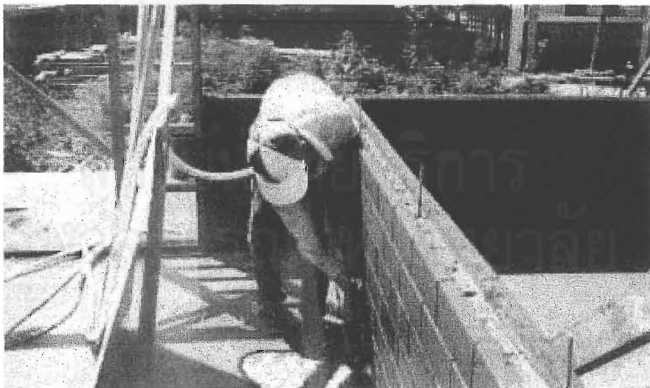
ภาพที่ 5-44 การล้างทำความสะอาดบล็อกดินซีเมนต์หลังจากการหยอดน้ำปน
