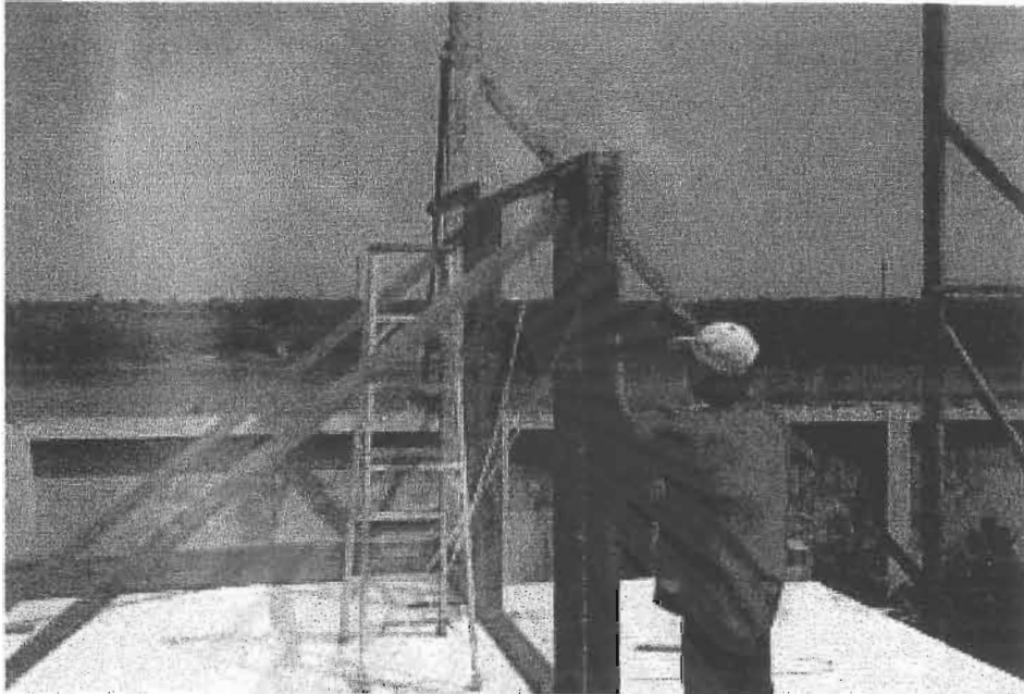
ภาพที่ 5-36 การป้องกันปลวกและแมลงที่จะทำลายวงกบ โดยการทาน้ำยากันปลวก
