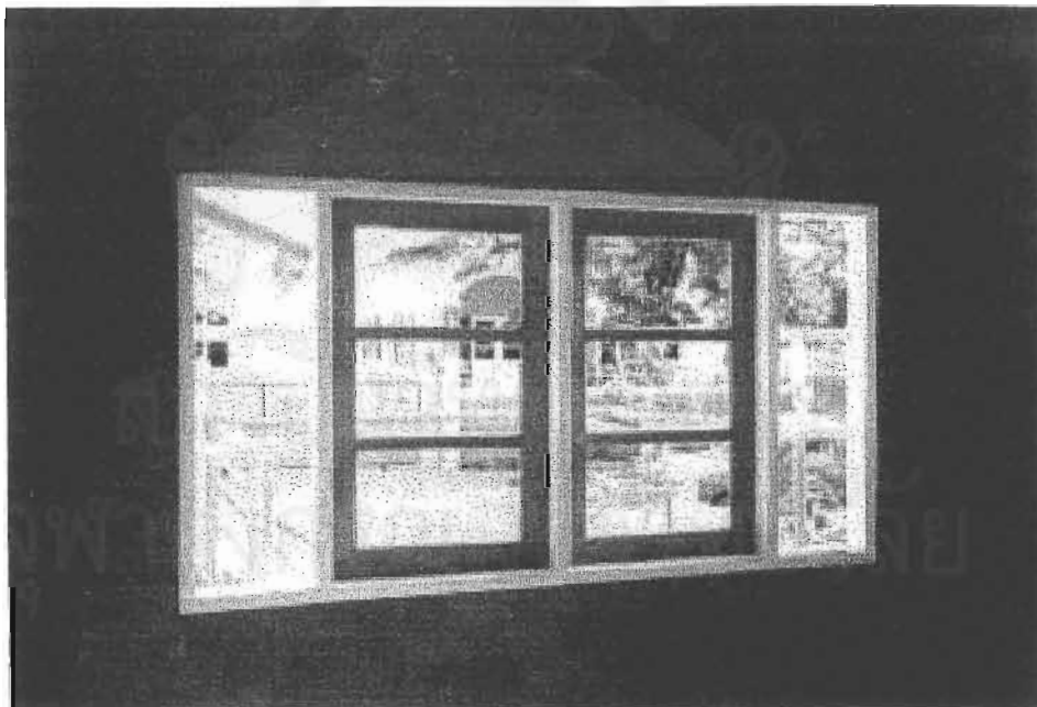
ภาพที่ 5-3 ขนาดของวงกบมีขนาดไม่พอดีกับการก่อบล็อก
