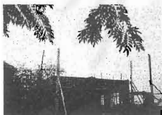
ก่อนล็อกช่วงที่ 3 จากหลังวงกบถึง อะเสโครงหลังคา วันที่ 5/11/2542 (ทำงานจริงได้ 18 วัน)
