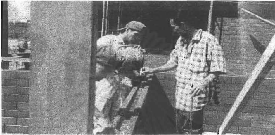
ภาพที่ 5-43 การหยอดน้ำปนทรายในรูบล็อกดินซีเมนต์
