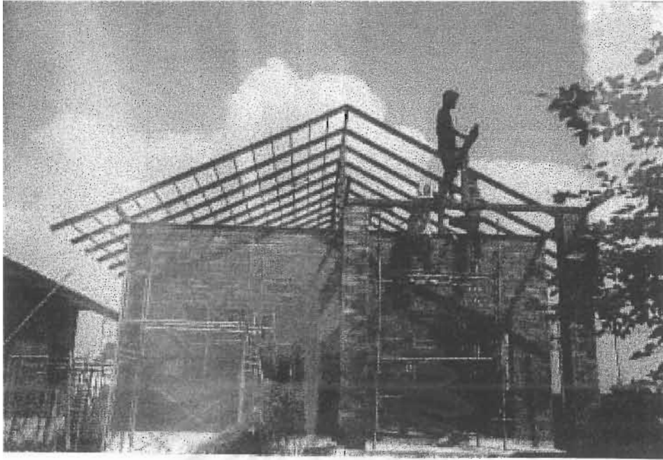
ภาพที่ 5-52 การติดตั้งโครงหลังคาเหล็ก
