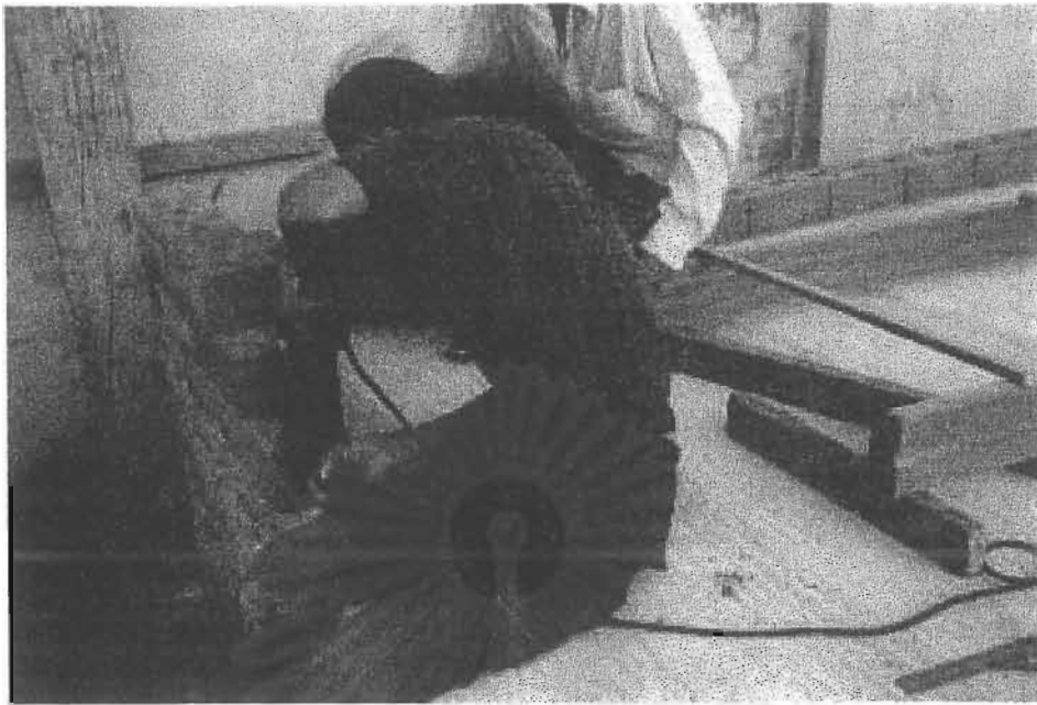
ภาพที่ 5 - 34 เจาะพื้นเตรียมเสียบเหล็กสำหรับยึดขวงกบให้แข็งแรง
