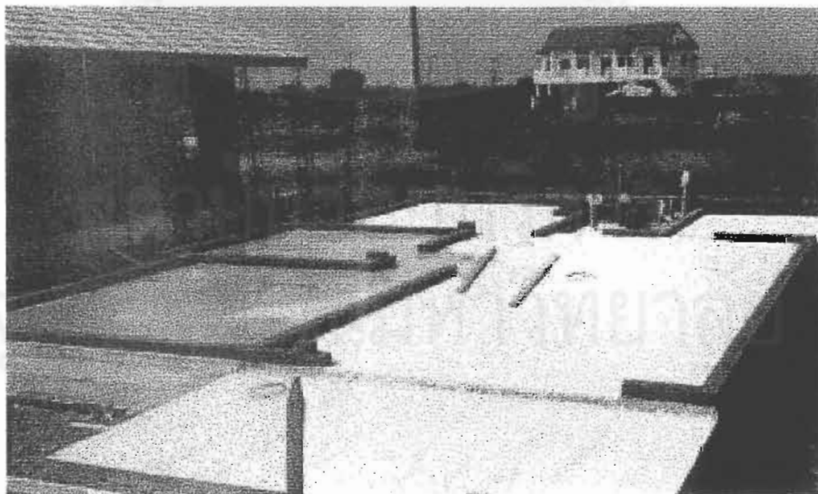
ภาพที่ 5-29 โครงสร้างของอาคารที่เตรียมไว้สำหรับการกอบล็อก
