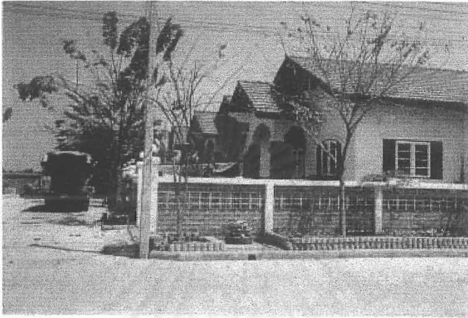
ภาพที่ 4-4 ทัดนียภาพโดยรวมของบ้านแบบก่ออิฐฉาบปูน
