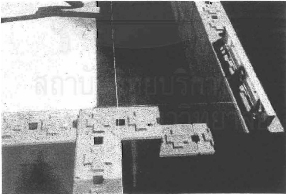
ภาพที่ 5-38 ส่วนที่มีการต่อของบล็อกจะต้องมีการตัดแต่งบล็อกโดยใช้เครื่องตัด
