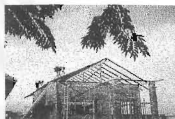
ติดตั้งโครงหลังคาเหล็ก วันที่ 9/11/2542 (ทำงานจริงได้ 21 วัน)
