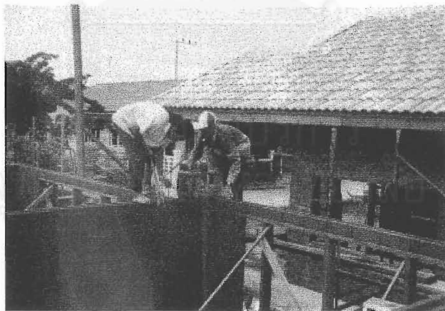
ภาพที่ 5-50 คนงานกำลังหยอดน้ำปูนทรายลงไปในส่วนของบล็อก
