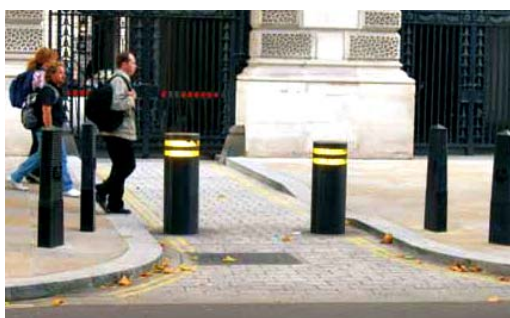
ภาพ 23 เสาเตี้ย กั้นทางเข้า-ออก เพื่อกั้นรถที่ไม่ได้รับเชิญเข้าสู่อาคาร
