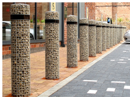
ภาพ 24 เสาเตี้ย กั้นการปะทะจากรถยนต์และรถจักรยานยนต์บนทางเท้า
