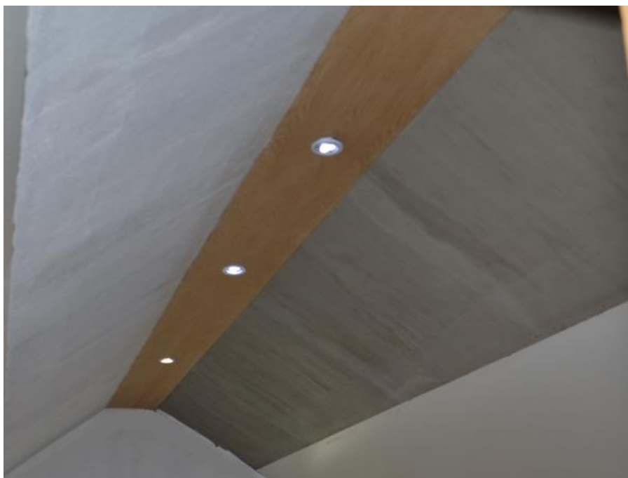
ภาพที่ 4.33 ทดสอบไฟฟ้าแสงสว่างภายในบ้านลอยน้ำ
