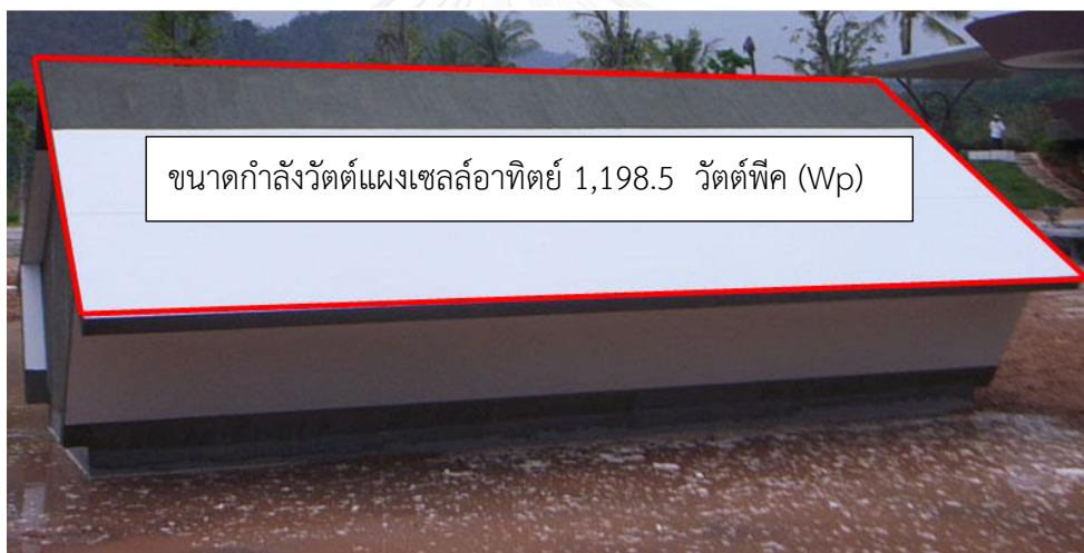
ภาพที่ 4.11 แสดงขนาดกำลังวัตต์แผงเซลล์อาทิตย์รวม 1,198.5 วัตต์พีค (Wp)
