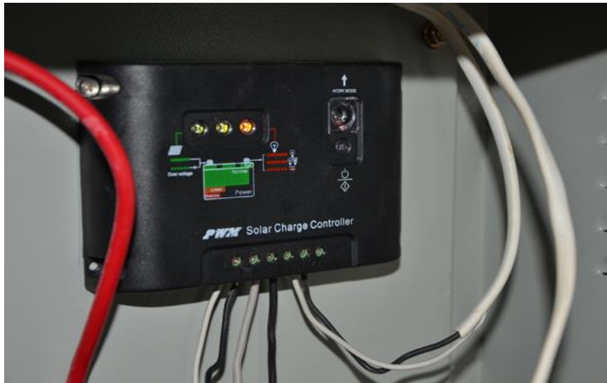
ภาพที่ 4.17 ภาพอุปกรณ์ควบคุมการชาร์จชนิด PMW ขนาดไม่เกิน 50 แอมป์
