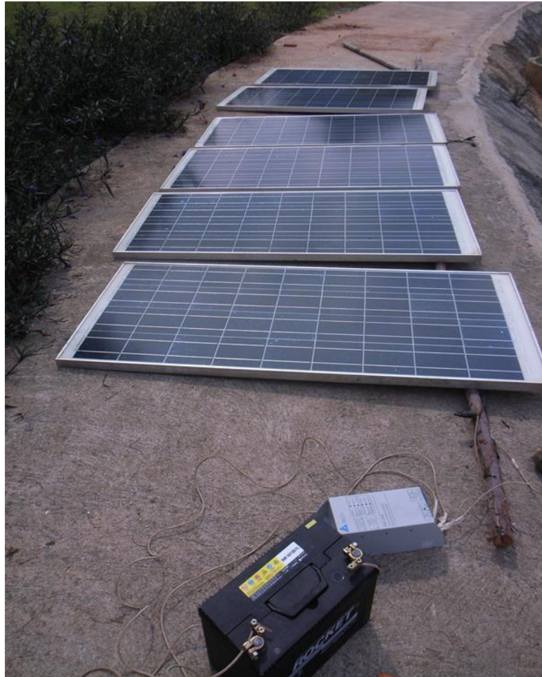
ภาพที่ 4.26 เตรียมชุดแบตเตอรี่และ อินเวอร์เตอร์
