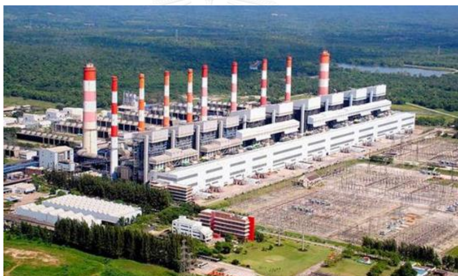
ภาพที่ 2.28 โรงไฟฟ้าถ่านหินแม่เมาะผลิตไฟฟ้ากระแสสลับเข้าระบบเครือข่ายไฟฟ้าเชื่อมสายส่ง [30]
