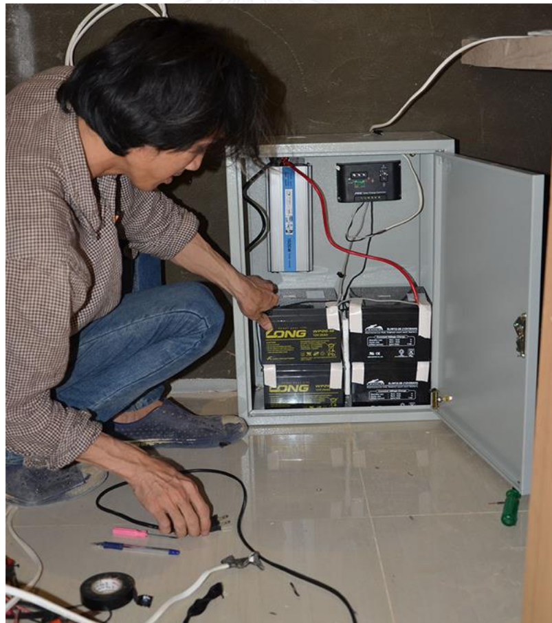
ภาพที่ 4.28 ติดตั้งชุดแบตเตอรี่ และ อินเวอร์เตอร์ ไว้ในตู้
