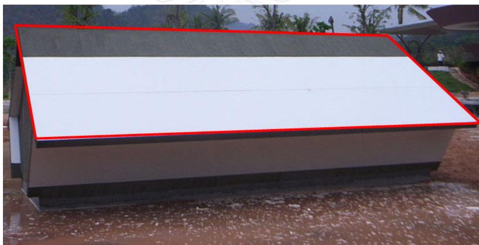
ภาพที่ 4.1 แสดงภาพขนาดพื้นที่หลังคาบ้านลอยน้ำ รวม 29.40 ตารางเมตร
