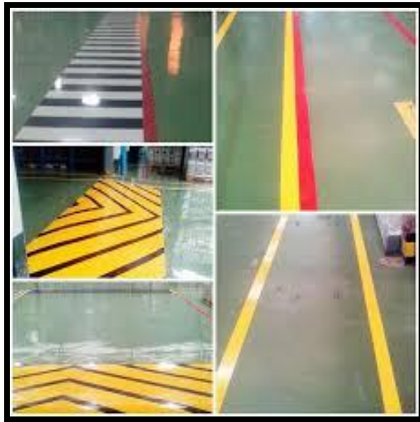
รูปที่ 6.6 ตัวอย่างการขีดเส้นบอกทางและบริเวณที่วางเครื่องจักร (ที่มา : http://data.thaiauto.or.th/iu3/ )
