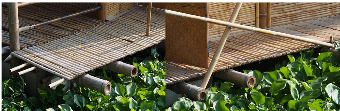
รูปที่ 4.36 พื้นปูฟากไม้ไผ่มีระดับสม่ำเสมอ และพบปัญหาวัสดุแอนน้อยกว่าพื้นไม้ไผ่เต็มลำ
