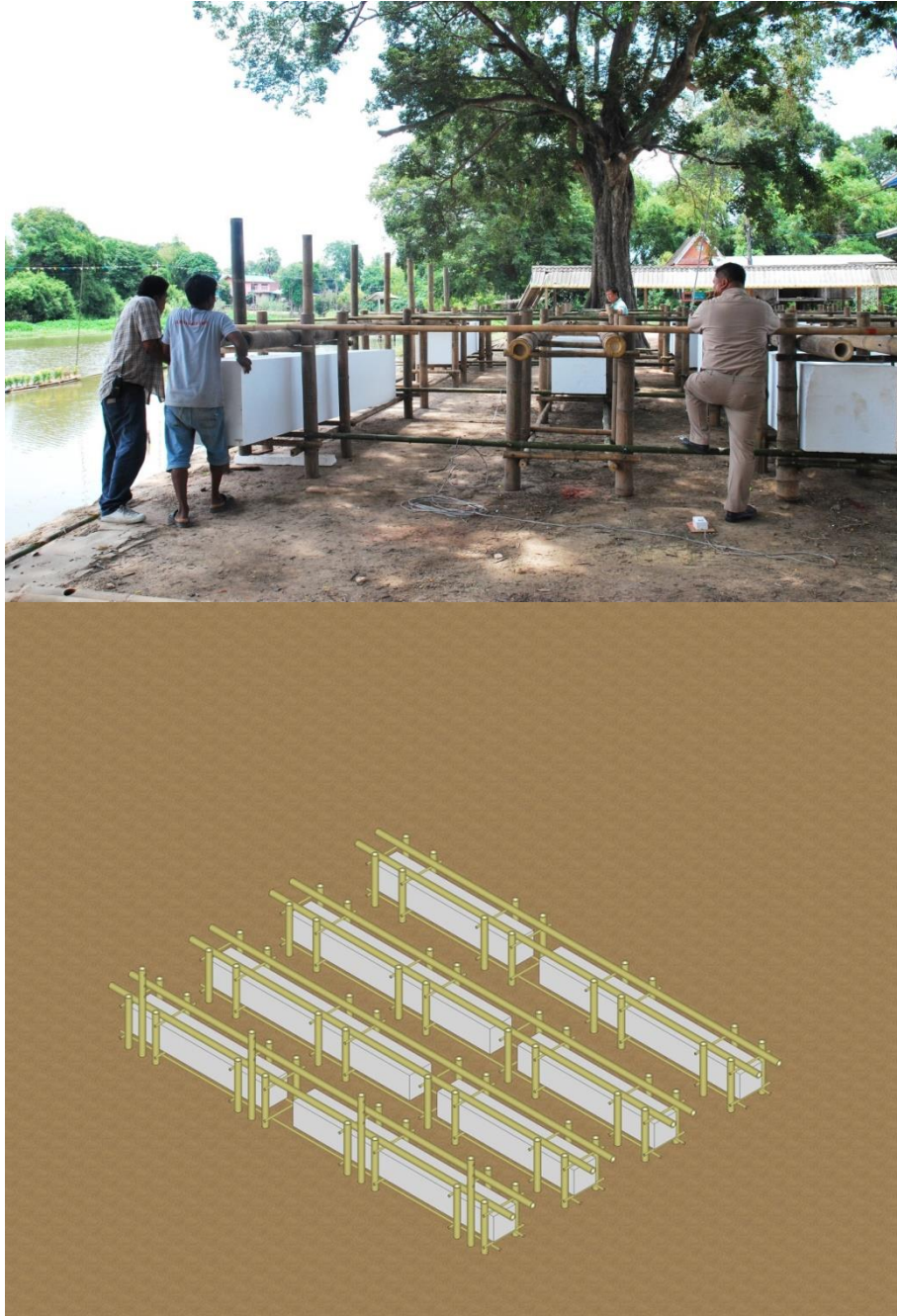
รูปที่ 3.23 ขั้นตอนการบรรจุฟุ้งโพน EPS เข้าในโครงฟุ้ง
