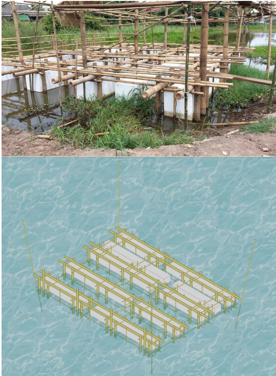
รูปที่ 3.28 ขั้นตอนการเสริมโฟม EPS
