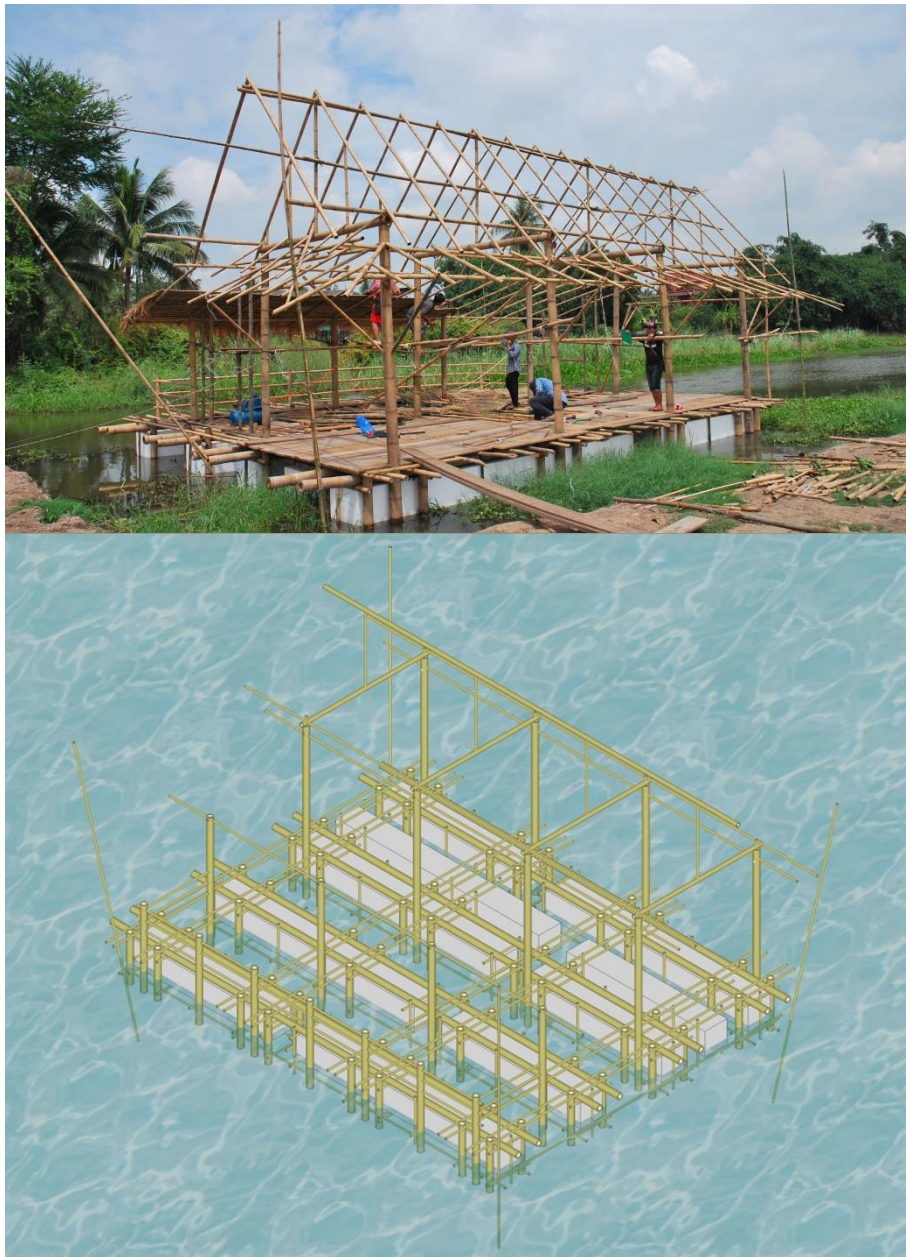
รูปที่ 3.34 ขั้นตอนการติดตั้งตั้ง และออกไถ่
