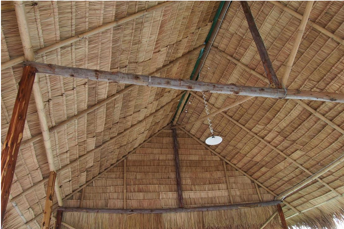
รูปที่ 3.48 ระบบไฟฟ้าแสงสว่างภายในอาคาร
