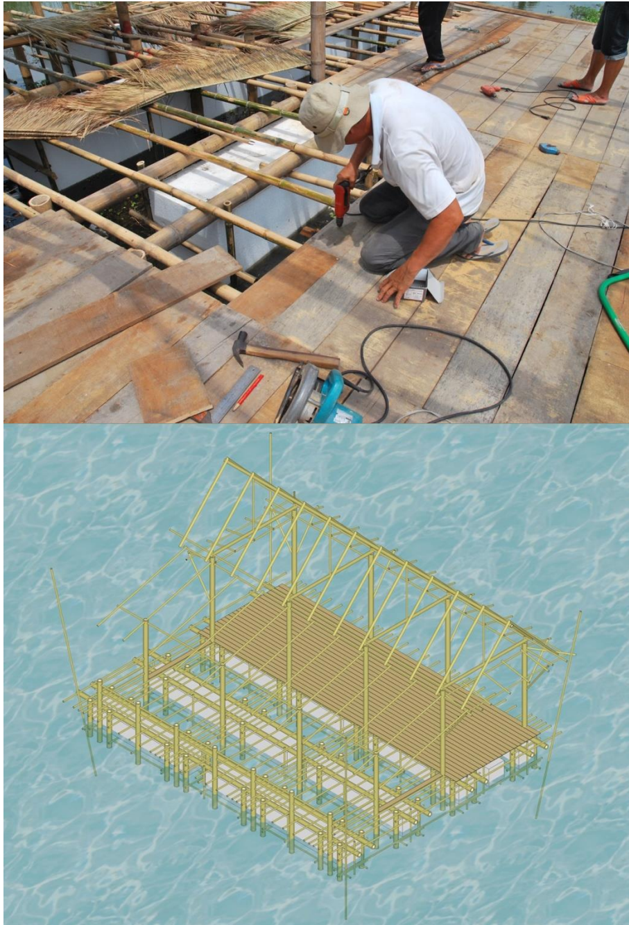
รูปที่ 3.38 งานติดตั้งพื้นไม้จริง
