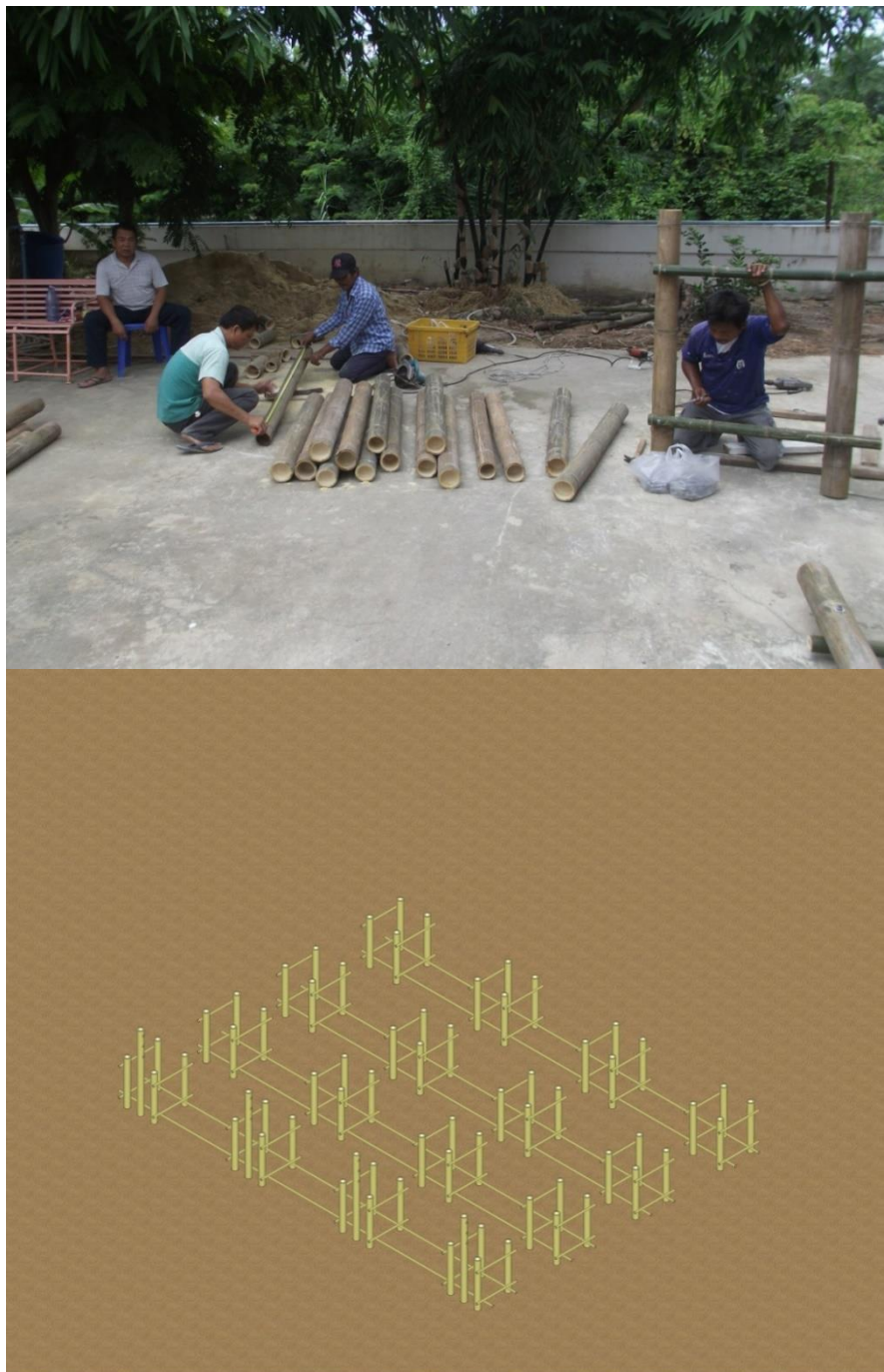
รูปที่ 3.20 ขั้นตอนงานประกอบโครงทุ่นลอย
