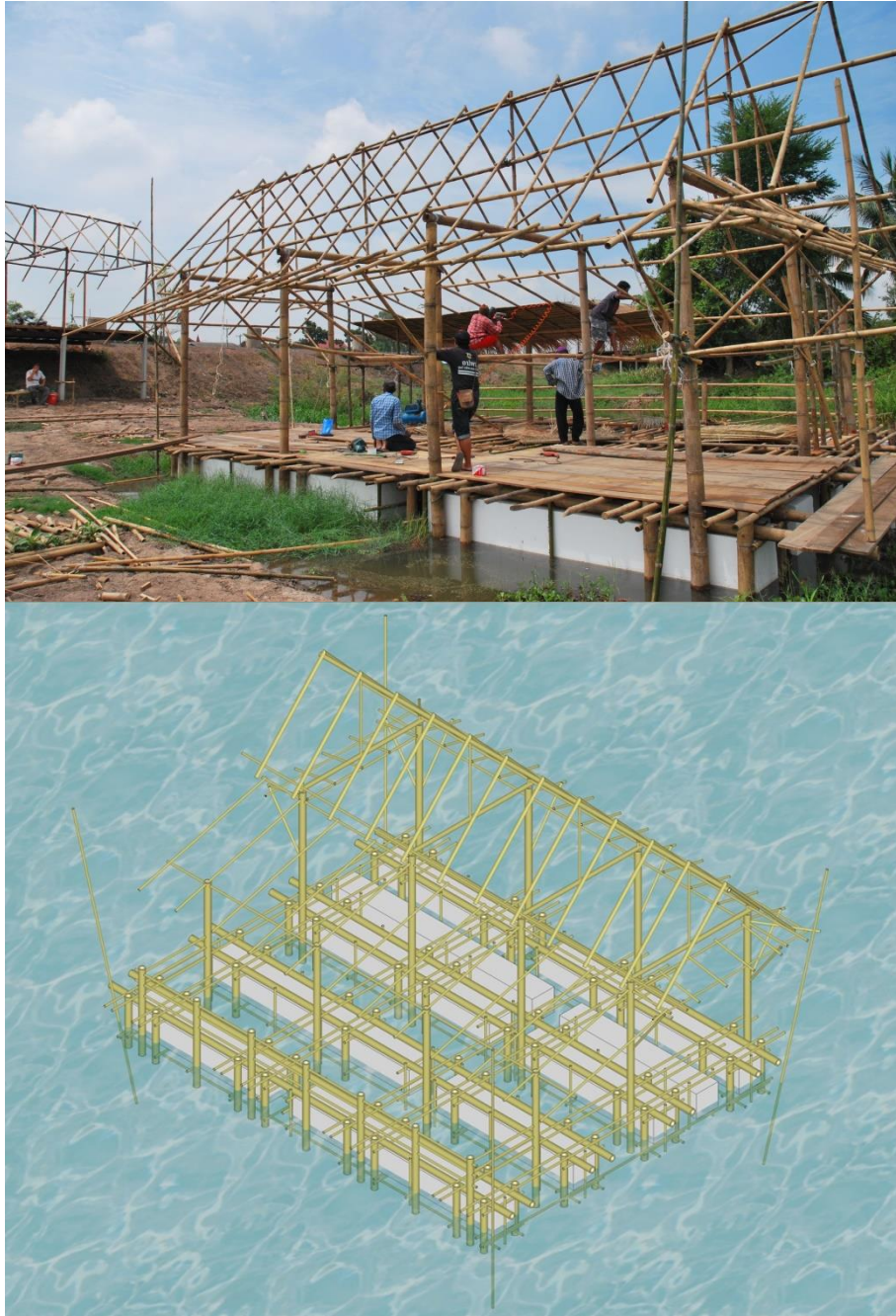
รูปที่ 3.36 ขั้นตอนการติดตั้งโครงหลังคาบ้านสาด
