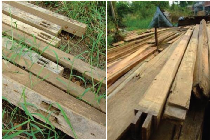
รูปที่ 2.2 คานแพ เสาเรือนแพ และรายละเอียดส่วนเชื่อมต่อระหว่างดินเสาและคานแพ ที่มา: อารยา เรืองคงเกียรติ, 2554
