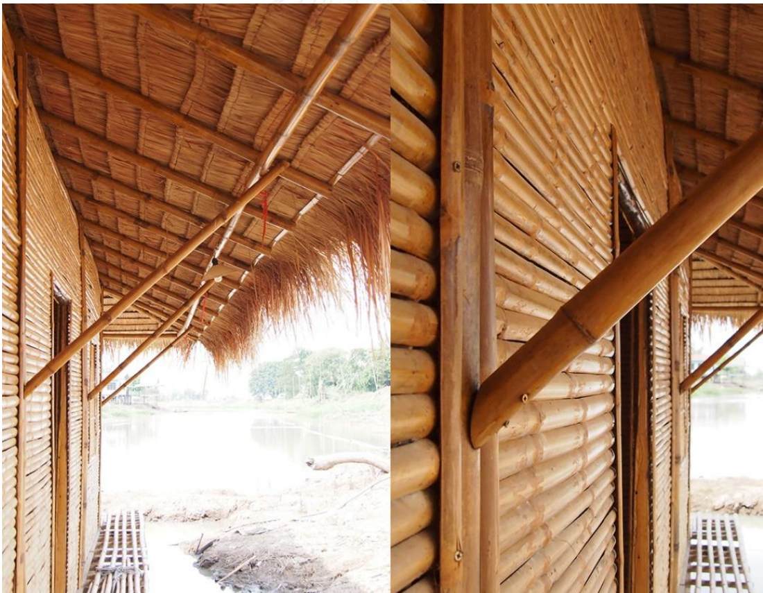
รูปที่ 4.32 ค้ำยันที่ตอกตะปูเข้ากับเสาอาคาร ทำหน้าที่รับน้ำหนักโครงสร้างกันสาด
