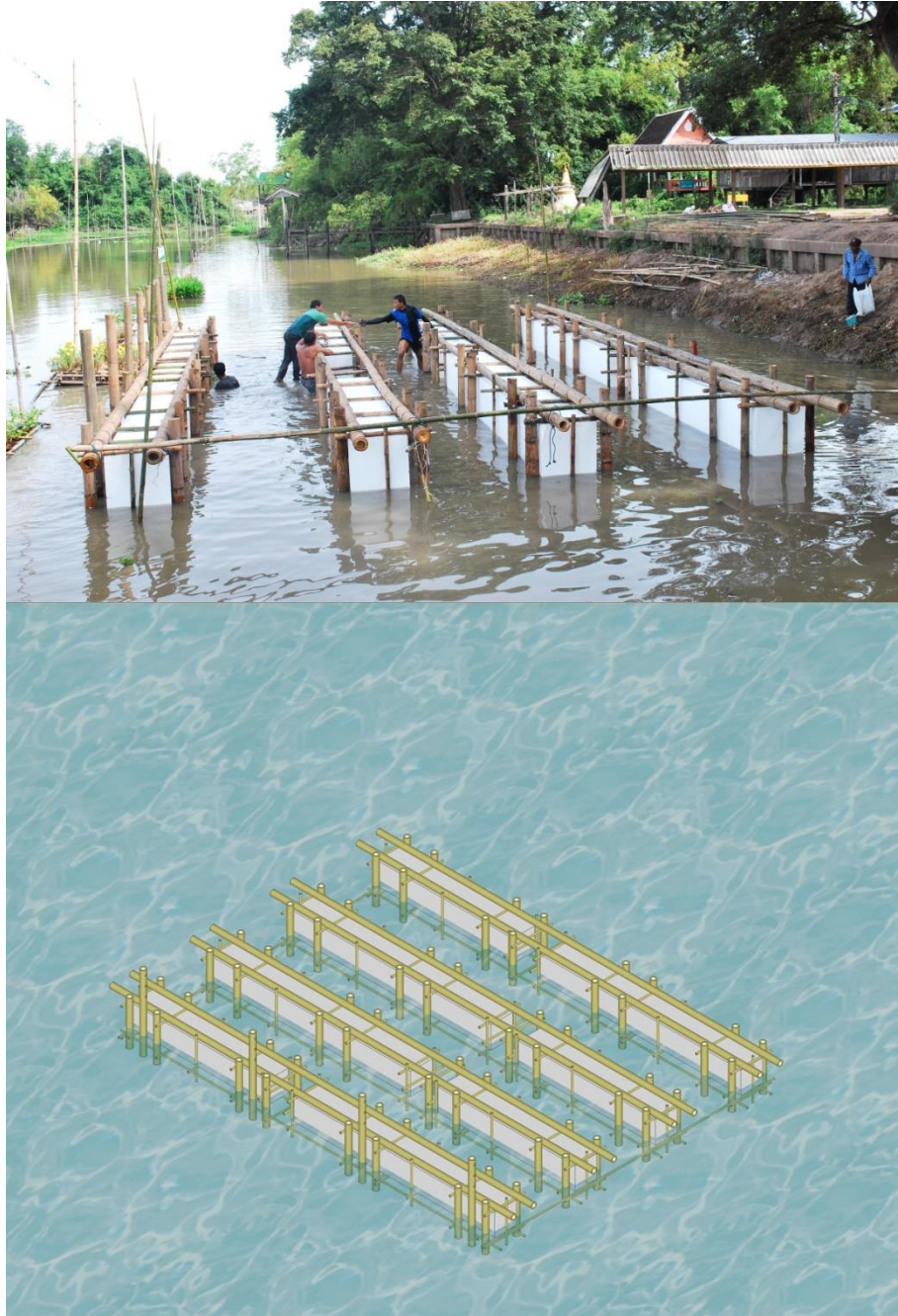
รูปที่ 3.26 ขั้นตอนการจัดเรียงตำแหน่งท่อน
