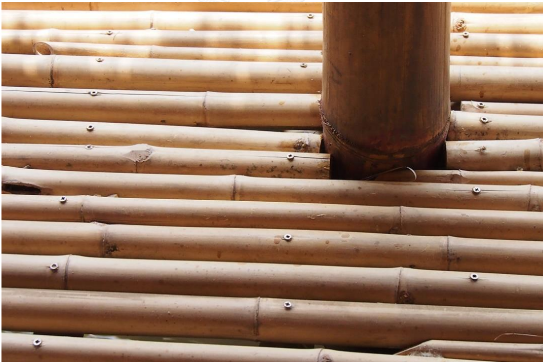
รูปที่ 4.34 แมลงกัดกินเนื้อไม้บริเวณหลังเส้นพาดเนื่องจากการติดตั้งผนังก่อนทาเคลือบน้ำยากันแมลง
