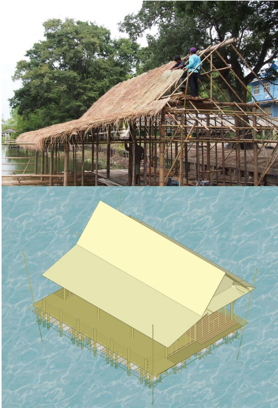
รูปที่ 3.41 ขั้นตอนการมุงหลังคา
