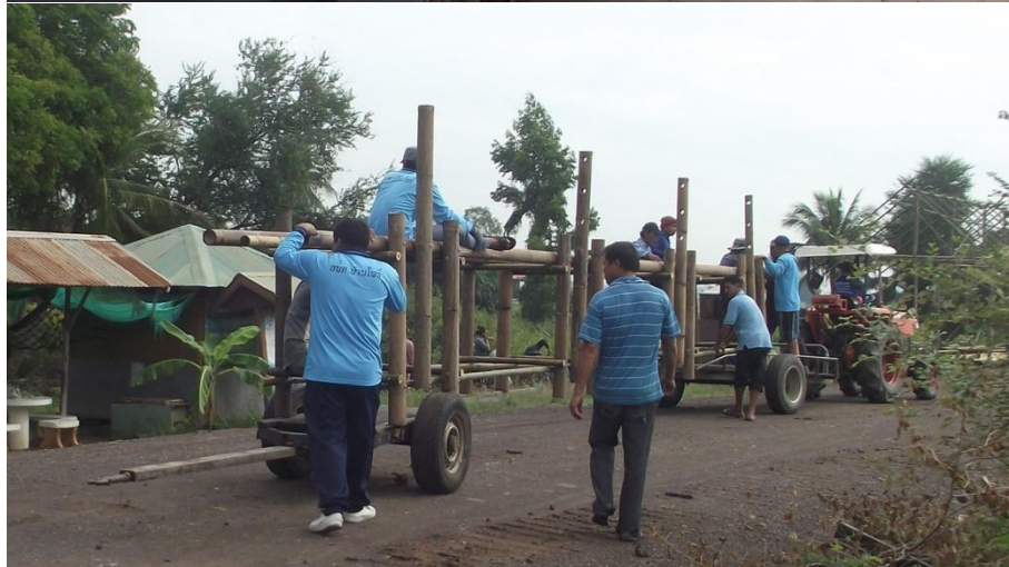
รูปที่ 3.22 ขั้นตอนการขนย้ายวัสดุและโครงท่อนลอยไปยังสถานที่ก่อสร้าง
