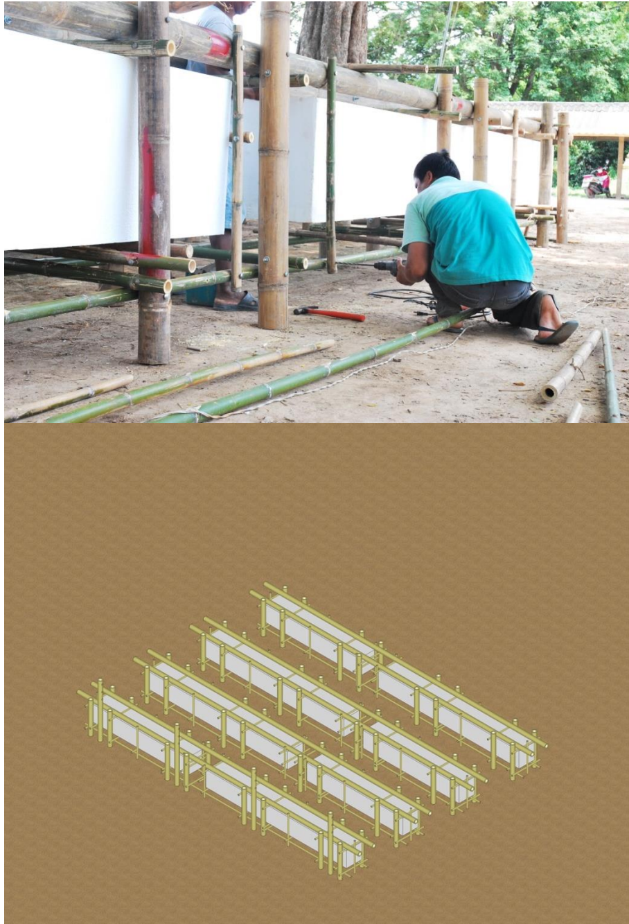
รูปที่ 3.24 ขั้นตอนการเสริมไม้ล๊อคทุ่นโฟม
