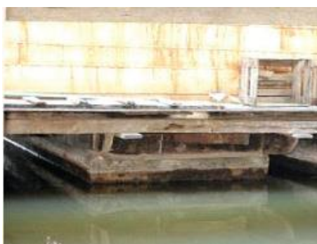
รูปที่ 2.1 รายละเอียดส่วนช่วยลอยประเภทแท่งเรือโครงสร้างไม้ฉาบปูน
