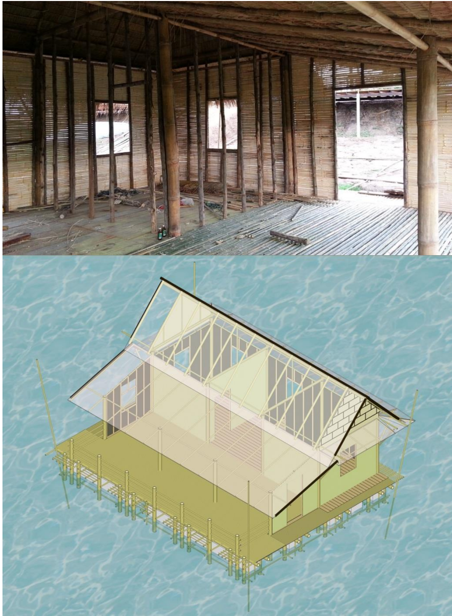
รูปที่ 3.43 ขั้นตอนการติดตั้งผนังภายนอก
