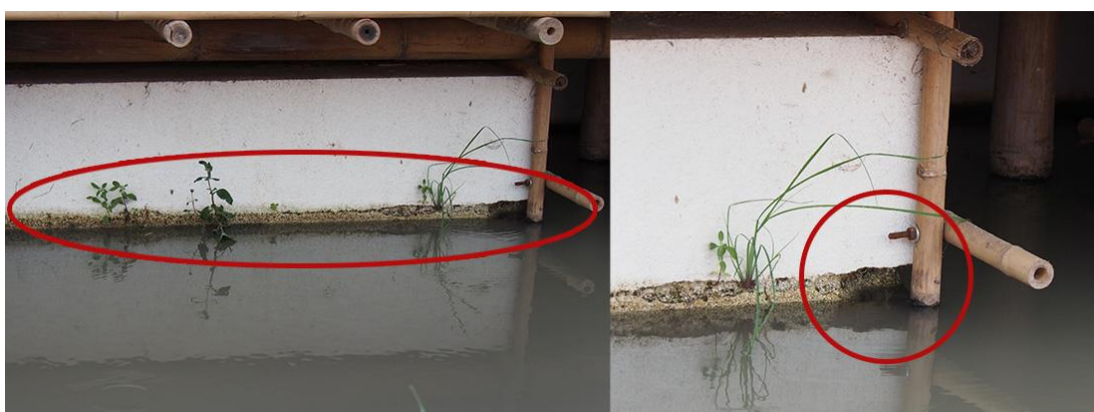
รูปที่ 4.28 ปัญหาความเสื่อมสภาพตามแนวปริ่มน้ำ
