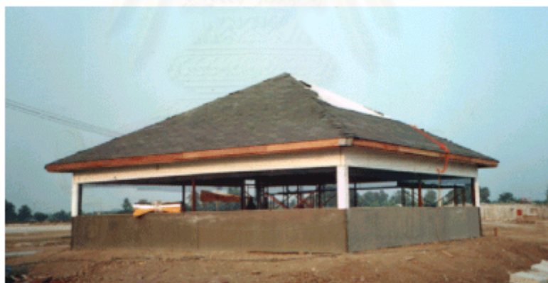
ภาพที่ 3.13 แสดงอาคารปรับอากาศที่กำลังอยู่ในระหว่างการก่อสร้าง ผนังทั้ง 4 ด้านของอาคารถูกเว้นช่องว่างเพื่อการติดตั้งวัสดุ
