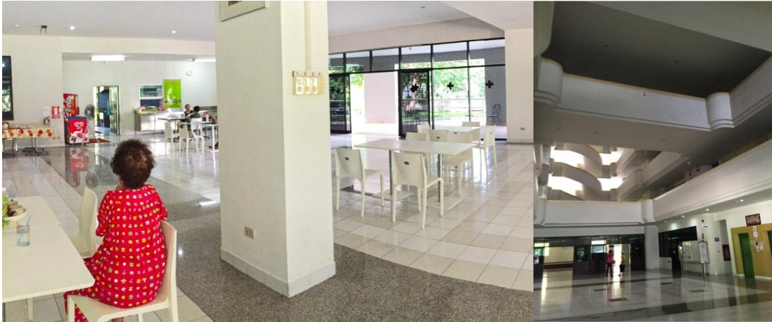
รูปภาพที่ 3. 1 พื้นที่โถงไม่ปรับอากาศได้อาคารเก่าโครงการสรวงคนิवास
