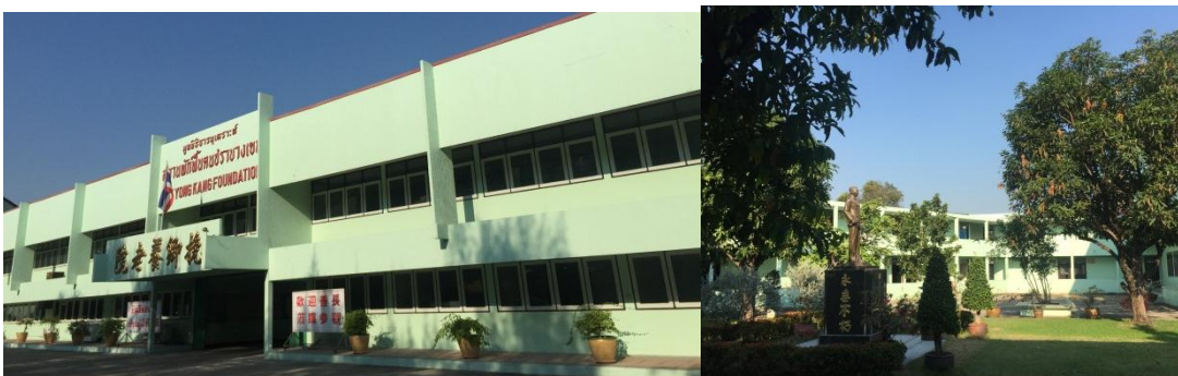
รูปภาพที่ 3. 6 พื้นที่หน้าโครงการและคอร์ทลานสนามหญ้าบริเวณกลางอาคาร
