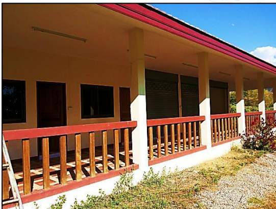
อาคารบริการนักท่องเที่ยว น้ำพุร้อนหนองครก
