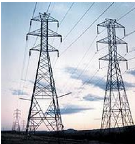
รูปที่ 3.1 เสาแบบเรียงสายส่งแนวตั้ง
