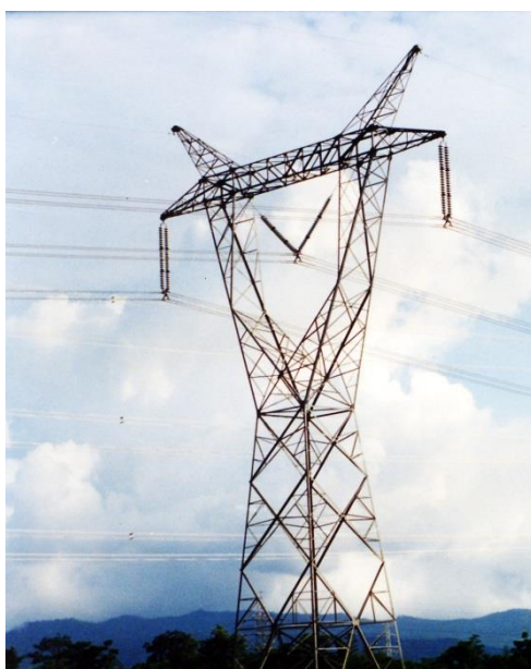
รูปที่ 2.1 เสาแบบเรียงสายส่งแนวนอน
