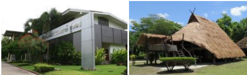
ภาพที่ 31 อาคารพิพิธภัณฑ์สถานแห่งชาติ อุทง และเรือนลาวโซ่ง ซึ่งตั้งอยู่บริเวณด้านทิศเหนือของตัวอาคาร
