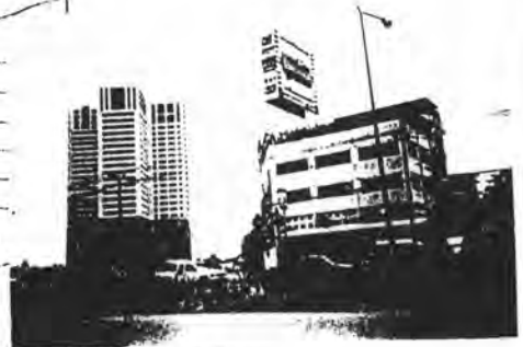
ขณะกำลังก่อสร้าง
