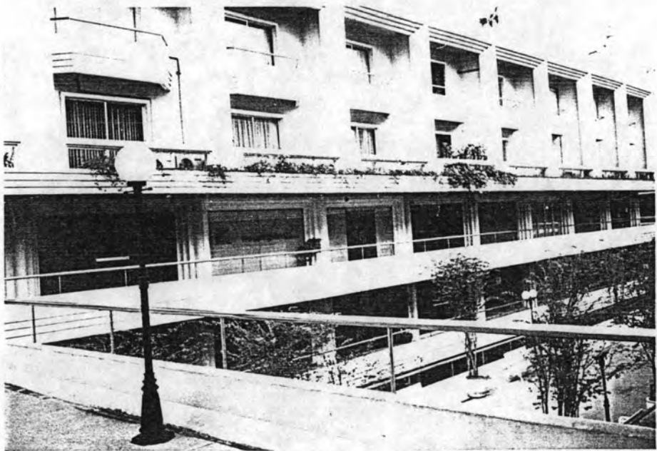
ภาพที่ 3.18 แสดงพื้นที่ชั้น 4 ขึ้นไป ที่ไม่มีทางเดินร่วมบริเวณระเบียง
