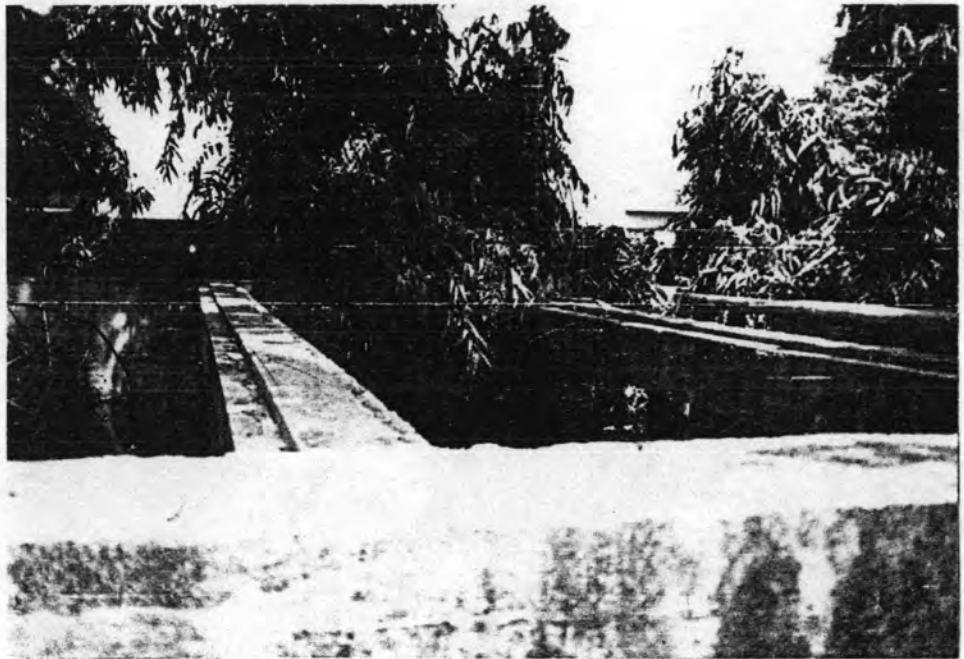
ภาพที่ 35 ภาพบ่อขังน้ำเสีย โครงการสยามคอนกรีตมิเนียม
