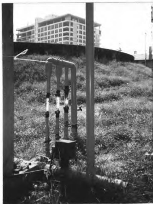
4. ตั้งเครื่องวัดอัตราการไหลและวาล์วเปิด/ปิดอัตโนมัติพร้อมทั้งปิดวาล์วทุกแห่ง
