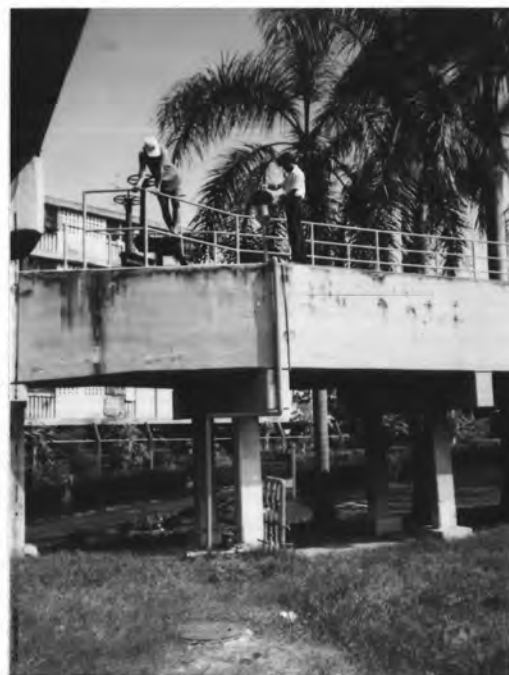
5. กรอกน้ำเสียผ่านกรวยกรองเข้าระบบจนเต็มท่อผ่านน้ำ
