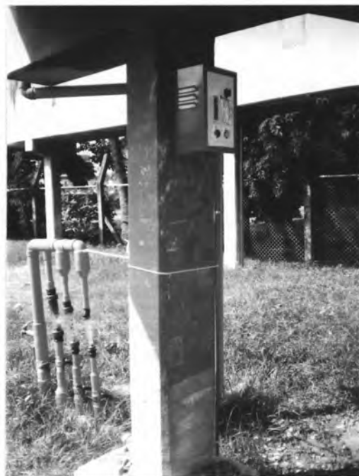
4. ตั้งเครื่องวัดอัตราการไหลและวาล์วเปิด/ปิดอัตโนมัติพร้อมทั้งปิดวาล์วทุกแห่ง
