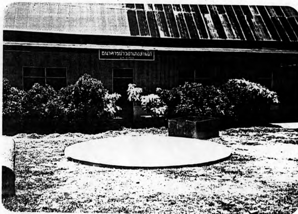
รูปที่ 4.14 แสดงส่วนที่เป็นฐานคอนกรีตของไซโลต้นแบบ
