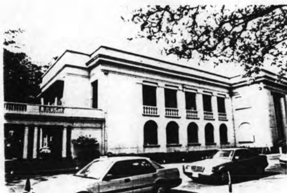
มุมมองจากถนนด้านหน้าอาคารด้านทิศE
