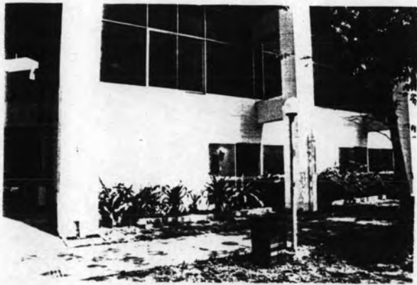
ด้านข้างอาคารของห้องอาหารที่ใช้วัดเก็บข้อมูลทิส
