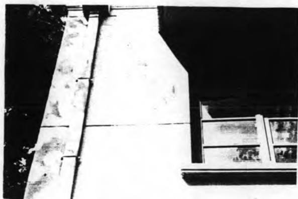
ผิวผนังก่ออิฐฉาบปูนทาสีขาวของอาคารด้านทิศW
