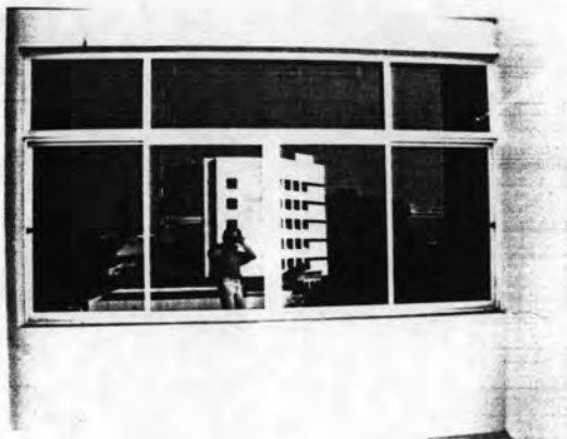
ผิวผนังก่ออิฐฉาบปูนทาสีขาวของอาคารด้านทิศ N
