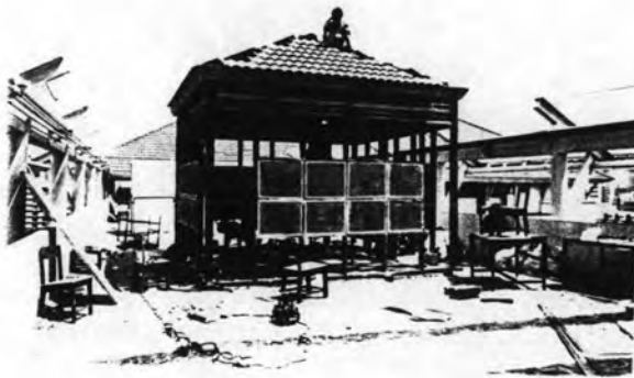
(5) งานผนังก่ออิฐฉาบปูนและผนังบานเกล็ดช่องลม
