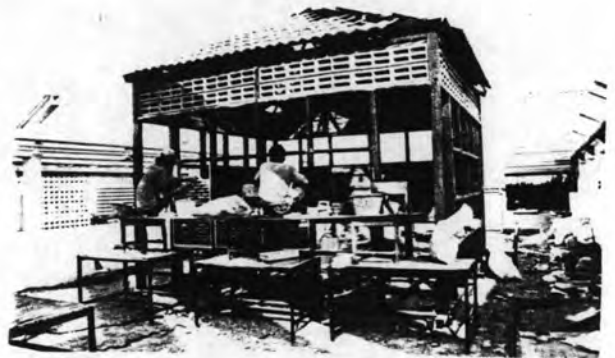
(4) งานโครงสร้างหลังคาและโครงผนังเหล็ก(ต่อ)
