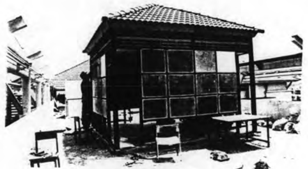
(6) งานผนังก่ออิฐฉาบปูน(ต่อ)
