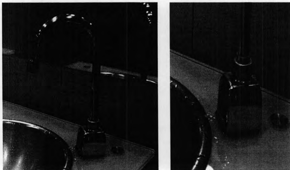
รูปภาพที่ 4-12 แสดงก๊อกน้ำอ่างล้างมือภายในอาคารผู้โดยสาร ท่าอากาศยานสุวรรณภูมิ
