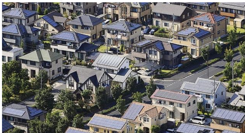
ภาพที่ 2.14 ตัวอย่างการติดตั้งระบบผลิตไฟฟ้าจากเซลล์แสงอาทิตย์ประเภทบนหลังคา ในประเทศญี่ปุ่น
