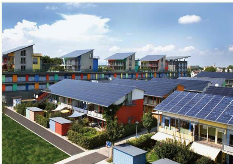
ภาพที่ 2.11 ตัวอย่างการติดตั้งระบบผลิตไฟฟ้าจากเซลล์แสงอาทิตย์ประเภทบนหลังคา ในประเทศเยอรมนี
