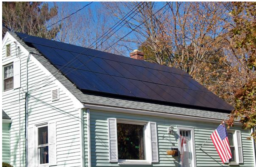
ภาพที่ 2.18 ตัวอย่างการติดตั้งระบบผลิตไฟฟ้าจากเซลล์แสงอาทิตย์ประเภทบนหลังคาในประเทศสหรัฐอเมริกา
