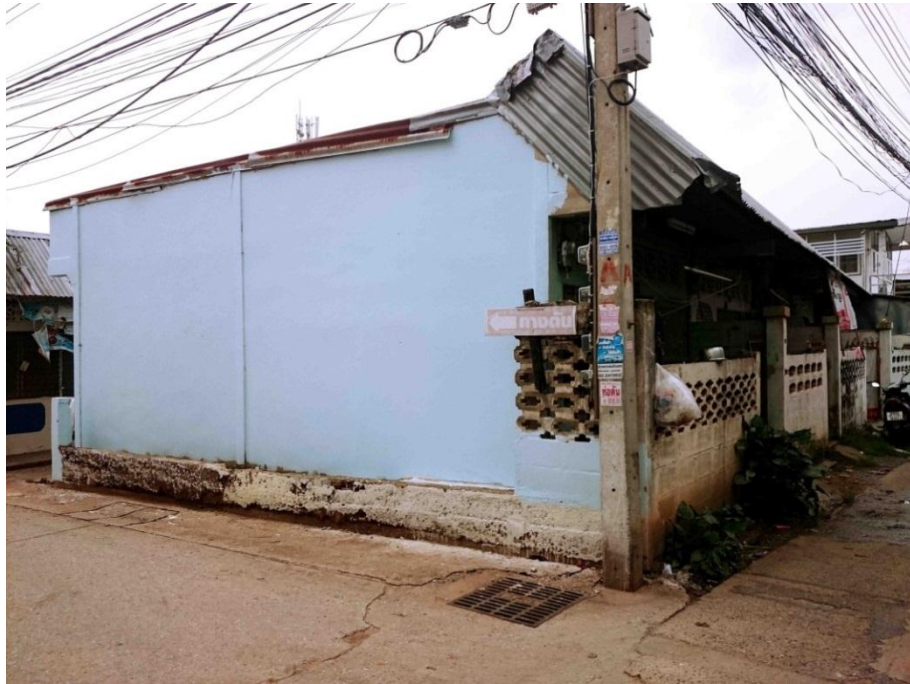
ภาพที่ 13 ภาพปากซอยทางเข้าบ้านหลังโรงไฟฟ้า ที่มา : สันติ วิลัยสูงเนิน
