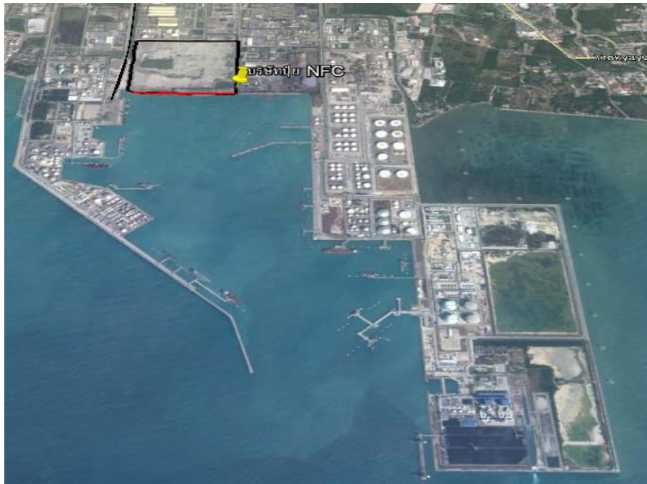
รูปที่ 4.1 พื้นที่ศูนย์กระจายถ่านหินบริเวณนิคมอุตสาหกรรมมาบตาพุด
