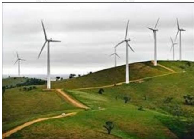
รูปที่ 2.9 โรงไฟฟ้าพลังงานลม
