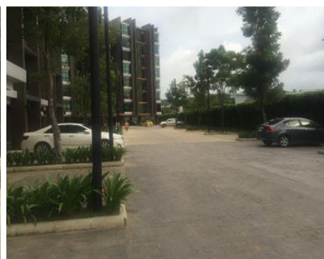
ภาพที่ 4.31 ลานจอดรถใต้อาคาร ที่มา : ผู้วิจัย (2559)
