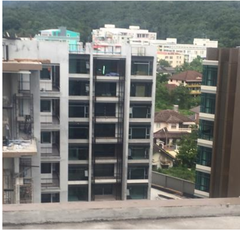
ภาพที่ 4.1 อาคารที่อยู่ระหว่างการก่อสร้าง ที่มา : ผู้วิจัย (2559)
