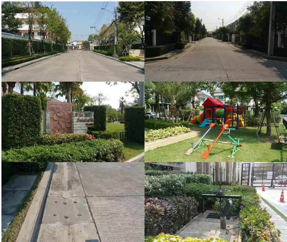
รูปภาพที่ 3- 55 แสดงสาธารณูปโภคภายในหมู่บ้าน ไหล่ บางกอก บูเลอวาร์ด รามอินทรา 23
