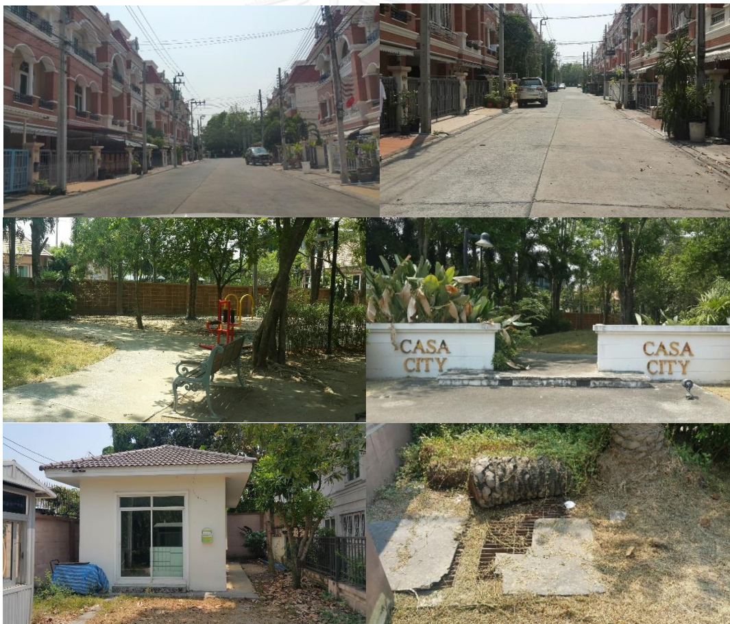
รูปภาพที่ 3- 98 แสดงสาธารณูปโภคภายในหมู่บ้าน คาซ่า ซิตี้ สุคนธสวัสดิ์ 1
