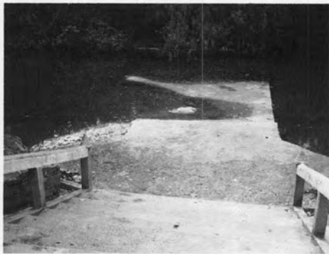
ฝายน้ำล้นคอนกรีตที่วัดหนองสาหร่าย อำเภอปากช่อง
