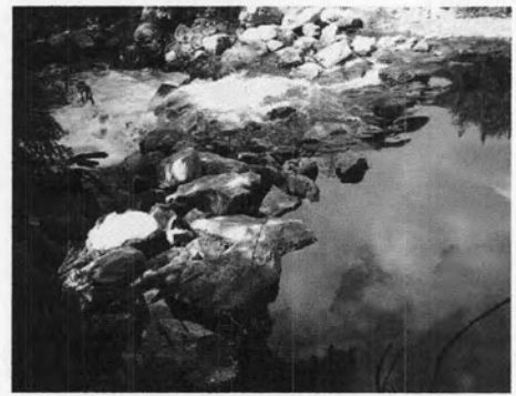
ฝายหินทิ้งก่อนถึงสะพานหนองสาหร่าย อำเภอปากช่อง
