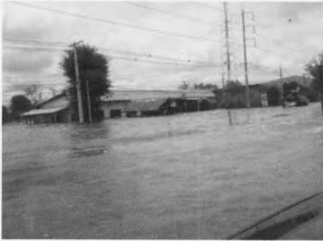
น้ำท่วมบริเวณถนนมิตรภาพ
