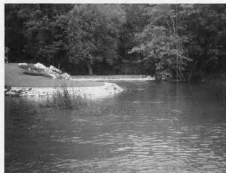
ฝายน้ำล้นบริเวณโรงแรมจุลดิศ อำเภอปากช่อง
