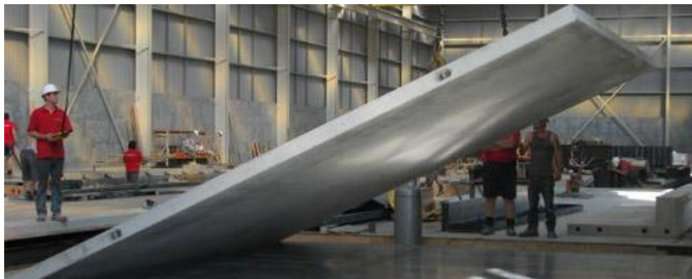
ภาพที่ 2.2 การถอดแบบโดยใช้จุดยกที่ฝังไว้ก่อนการเทคอนกรีต
