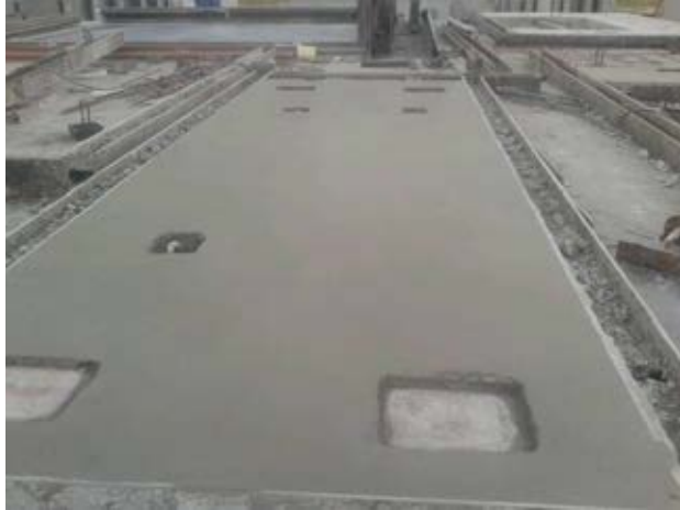
ภาพที่ 3.12 เทคอนกรีตแล้วเสร็จ
