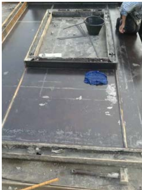
ภาพที่ 3.9 ทำความสะอาดโต๊ะแบบหล่อและทาน้ำมัน
