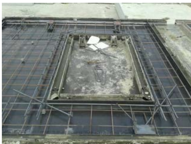
ภาพที่ 3.7 การวางแบบวางเหล็ก ติดตั้งเพรทและวางท่องานระบบ
