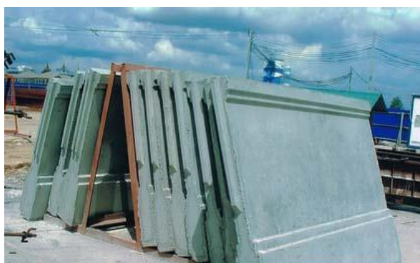
ภาพที่ 2.3 การขนย้ายชิ้นส่วนผนังคอนกรีตหลักการถอดแบบ
