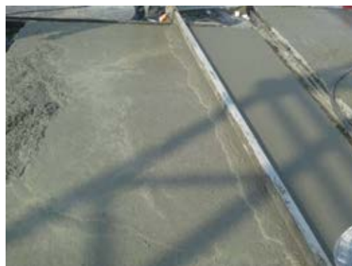
ภาพที่ 3.10 เทคอนกรีต พร้อมจี้ปูน
