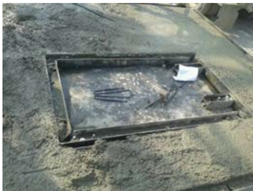
ภาพที่ 3.10 เทคอนกรีต พร้อมจี้ปูน
