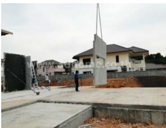
ภาพที่ 2.4 การยกติดตั้งผนังคอนกรีตหล่อสำเร็จ
