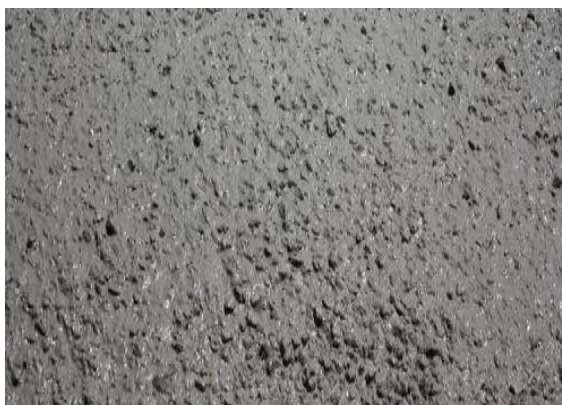
รูปที่ 2 คอนกรีต
