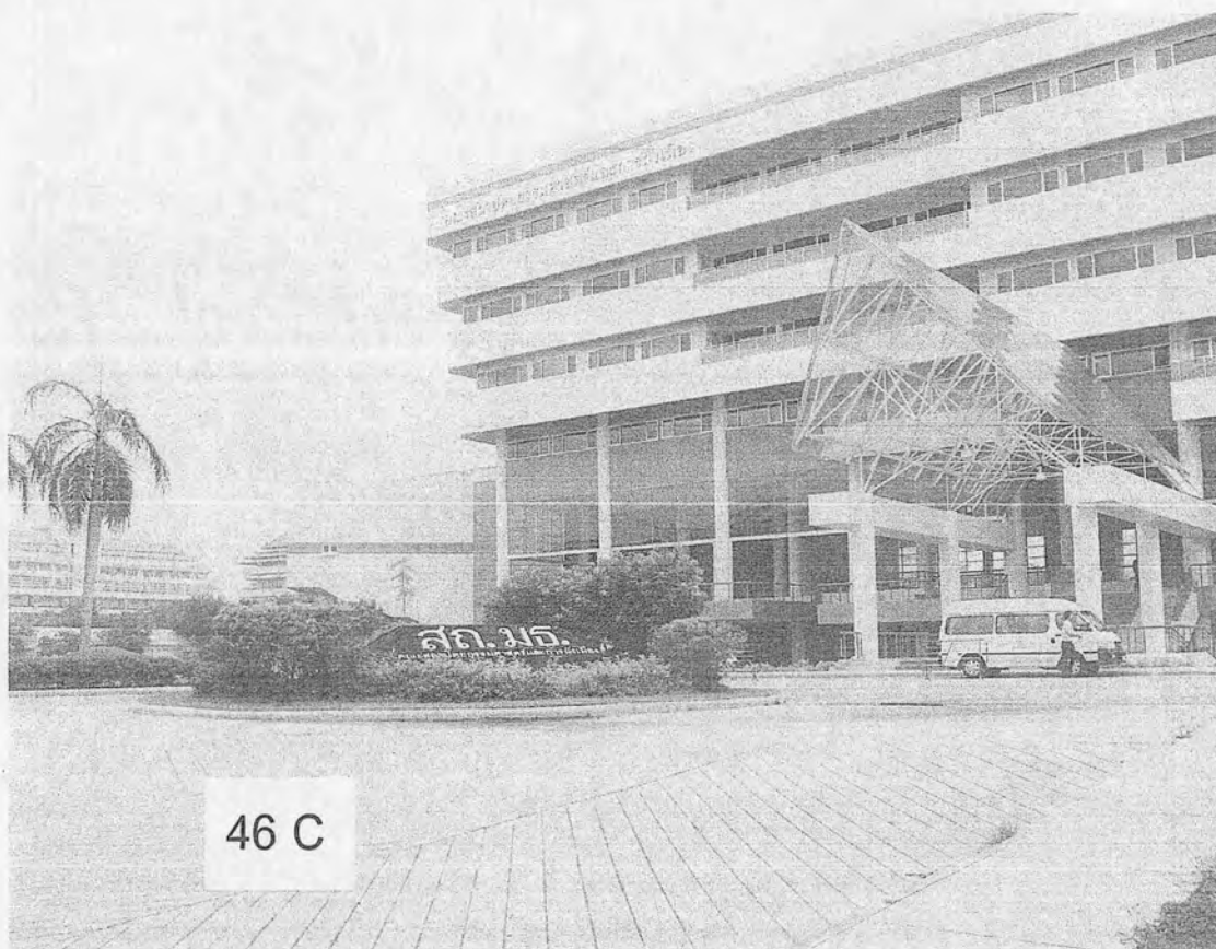
ภาพที่ 4-10 บริเวณทางเข้าอาคารเดิมและอุณหภูมิพื้นผิวโดยรอบสูง 46 อองศาเซลเซียส
