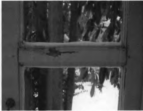
ภาพที่ 5.1 ขยายให้เห็นถึงความเสียหาย ของหน้าต่างบริเวณชานพักบันได
