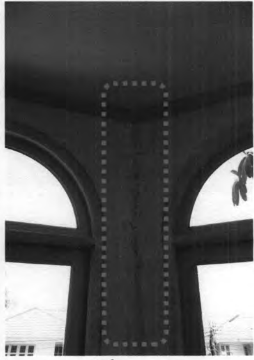
ภาพที่ 5.5 แสดงบริเวณจุดที่แตกร้าว บริเวณที่วางกระถางต้นไม้ชั้น 2 แบบบ้าน B
