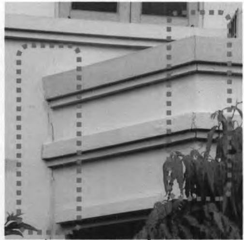
ภาพที่ 5.4 แสดงบริเวณจุดที่ก่อให้เกิดปัญหารั่วซึมบริเวณที่วางกระถางต้นไม้ชั้น2แบบบ้าน B
