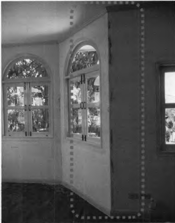
ภาพที่ 5.5 แสดงบริเวณจุดที่แตกร้าว บริเวณที่วางกระถางต้นไม้ชั้น 2 แบบบ้าน B
