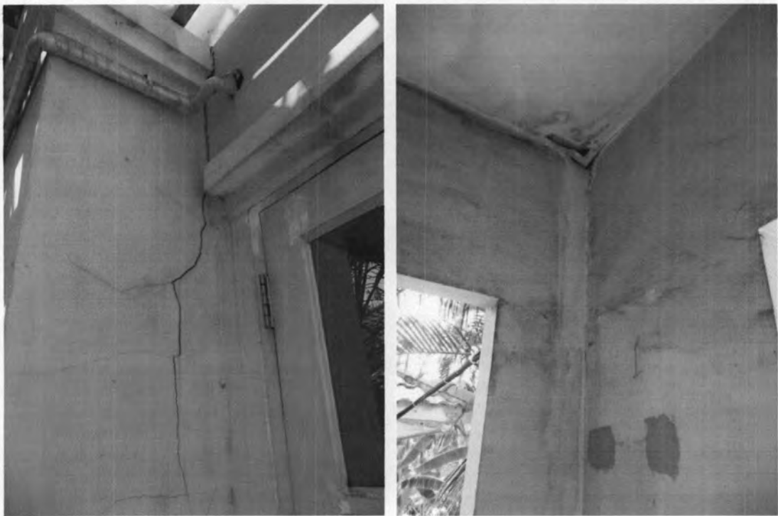
ภาพที่ 5.10 ภาพเสาดกแต่งภายนอกที่เป็นเสาก่ออิฐฉาบปูน ฉีกตัวออกจากผนัง
