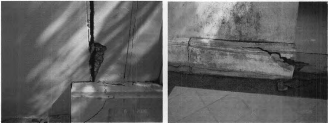
ภาพที่ 5.10 ภาพเสาดกแต่งภายนอกที่เป็นเสาก่ออิฐฉาบปูน ฉีกตัวออกจากผนัง
