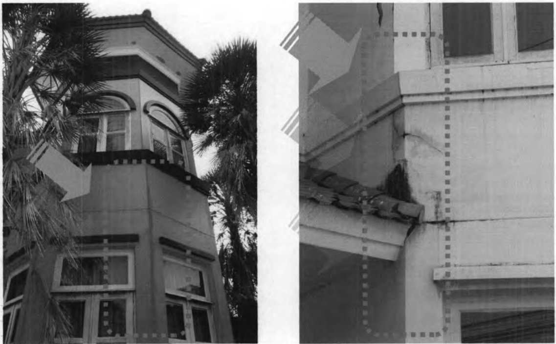
ภาพที่ 5.13 รูปรอยแตกร้าวภายนอก บริเวณรอยต่อของแผ่นสำเร็จรูป
