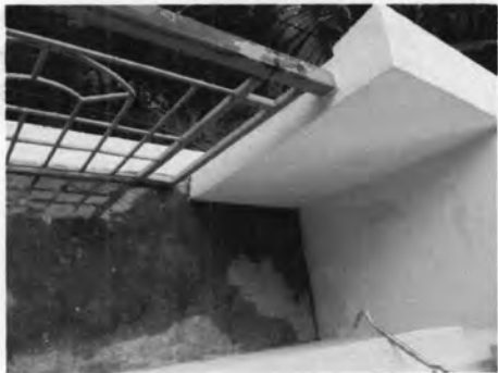
ภาพที่ 5.2 ขยายให้เห็นถึงจุดที่เกิดปัญหา บริเวณระเบียงวางเครื่องปรับอากาศ
