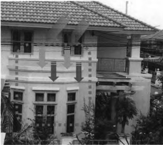
ภาพที่ 5.4 แสดงบริเวณจุดที่ก่อให้เกิดปัญหารั่วซึมบริเวณที่วางกระถางต้นไม้ชั้น2แบบบ้าน B
