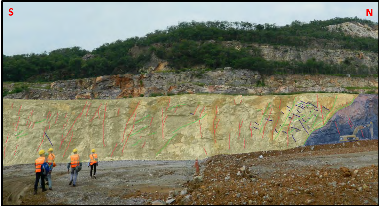
รูปที่ 3.16 พื้นที่ศึกษา Block 1 อยู่ทางตอนใต้ของพื้นที่ศึกษา มีความยาวประมาณ 100 เมตร แสดงระบบรอยแตก(Joint sets)ทั้งหมด 3 แนว และแสดงความสัมพันธ์ของการตัดกันของรอยแตกทั้ง 3 ระบบ(กลุ่มคนในรูปสูงประมาณ 165-175 เซนติเมตร)
