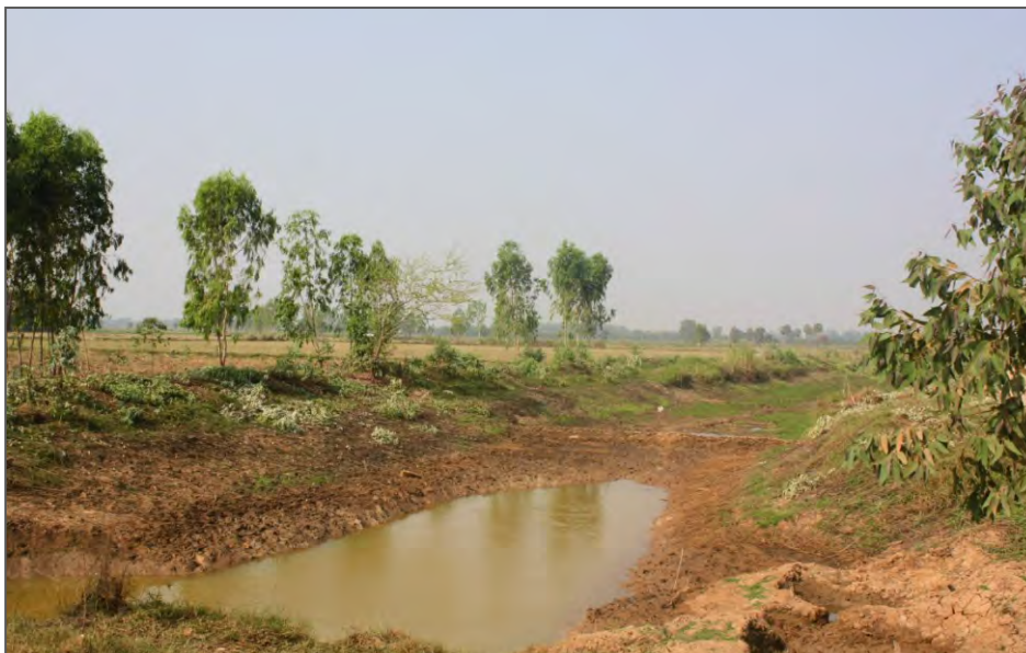
รูปที่ 4.14 คลองมีการขุดเพิ่มเติมเพื่อเป็นที่กักเก็บน้ำใช้ในการเกษตรกรรม
