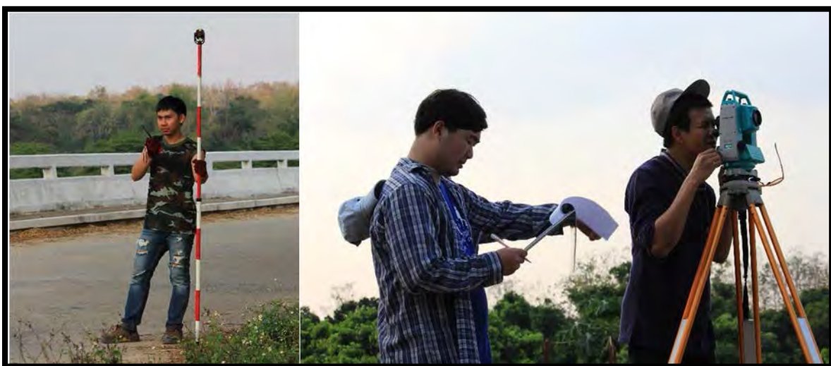
รูปที่ 3.6 แสดงการใช้กล้องสำรวจในกรณีที่สะพานโค้ง
