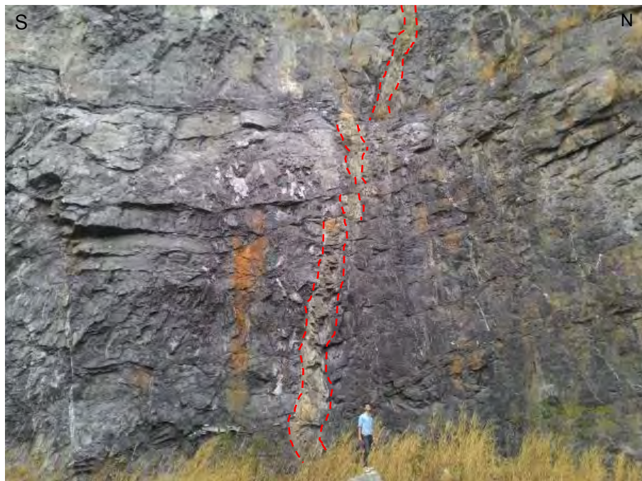
รูปที่ 3.19 ภาพรวมของพื้นที่ศึกษา C (Zone: C) วางตัวในแนวเหนือ-ใต้เป็นบริเวณที่พบรอยแตกในแนวตั้ง (Vertical fracture) ซึ่งแบบทั้งรอยแตกและผนังหินแอนดีไซต์ที่แทรกตัดผ่านชั้นหินและชั้นหินคดโค้งในพื้นที่ศึกษา
