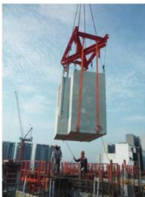
รูปที่ 2.6 แสดงรูปแบบการยกห้องน้ำสำเร็จรูปด้วยสายพาน
